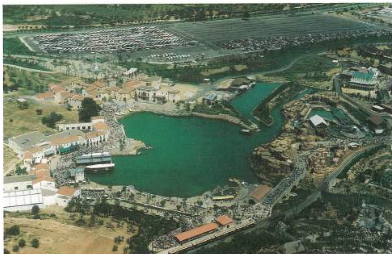
PORT AVENTURA (TARRAGONA) 1994. 82.000 m 2 impermeabilizados con DRAYFIL.
