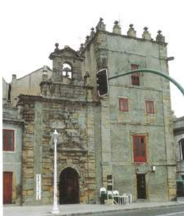
FOTO 1. Estado actual de la ermita de San Lorenzo, en la escalonera. Gijón (Asturias).
