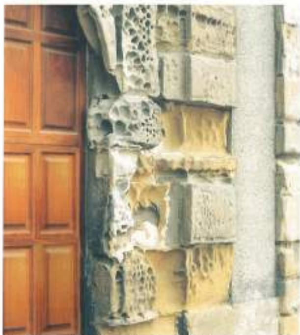
FOTO 5. Zonas de arenización de sillares, producidas, en algunos casos, a consecuencia de los procesos de alveolización.
