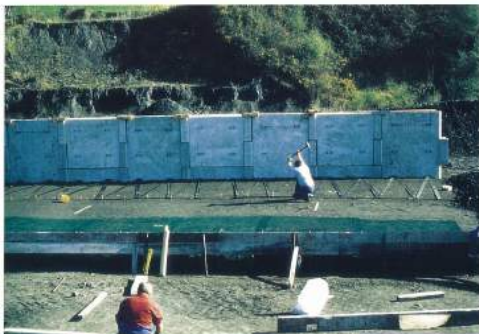
FOTO 2. Estructura de tierra armada. Colocación de armaduras.
