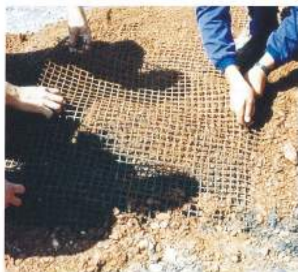
FOTO 4. Estructura de tierra armada. Extracción de muestras de armaduras.
