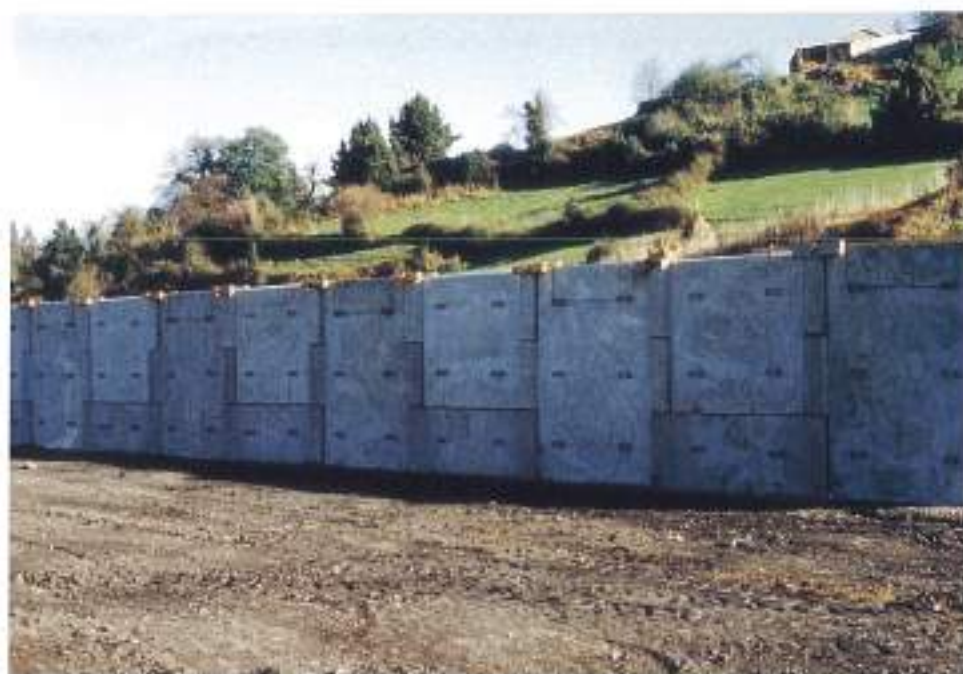
FOTO 1. Estructura de tierra armada. Muro de escamas tipo Freysinets.
