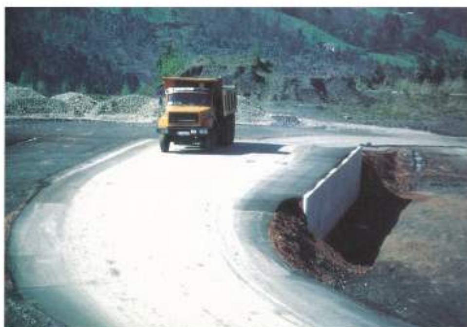
FOTO 3. Estructura de tierra armada. Generación de tráfico.
