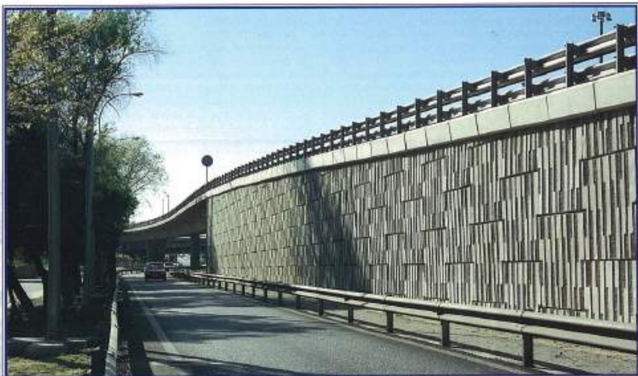
Remodelación del enlace de la N-II y la M-40. Enlace Barajas. Madrid.
