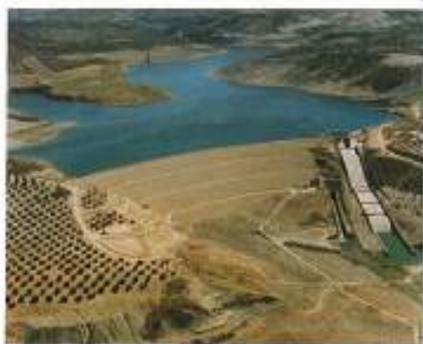
Presa de Vadomojón. Baena, Córdoba
