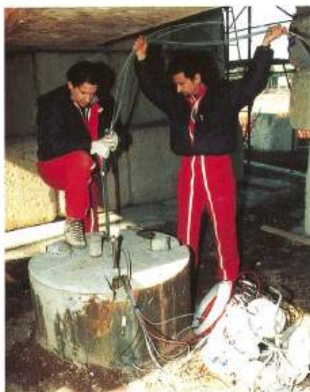
FIGURA 6a. Inserción del extensómetro dentro de un pilote perforado de 34 m de longitud y diámetro 1000 mm (Roma, Italia, 1996).
