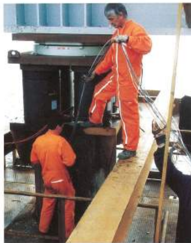
FIGURA 6b. Inserción del extensómetro dentro del pilote hincado de 80 m, del futuro puente Vasco da Gama a Lisboa.
