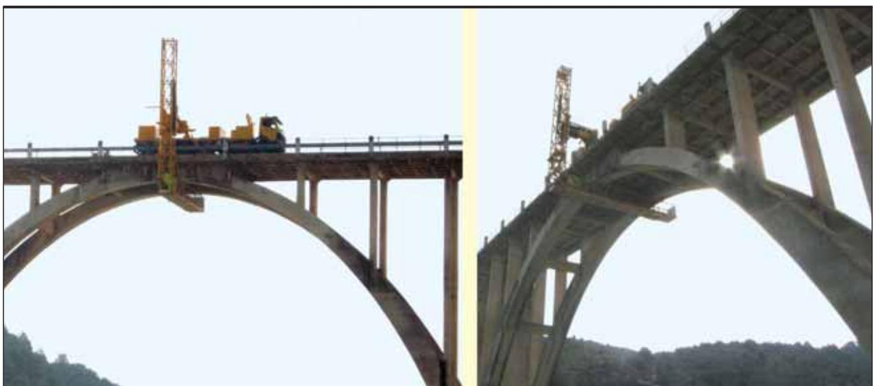
FIGURA 3. Vista de los vanos centrales y de la pasarela para la inspección de puentes.
