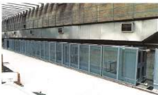
FOTO 3. Vista del banco de pruebas terminado.
