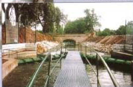
REGULACION DE NIVEL Y DISTRIBUCION Canal del Duero Compuertas AVIS y Módulos de Máscara C
