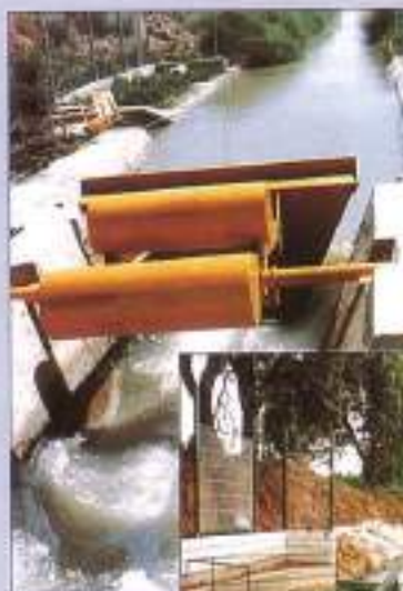
REGULACION DE NIVEL Y DISTRIBUCION Compuerta AMIL y Módulos de Máscara XX Canal Aragón-Cataluña
