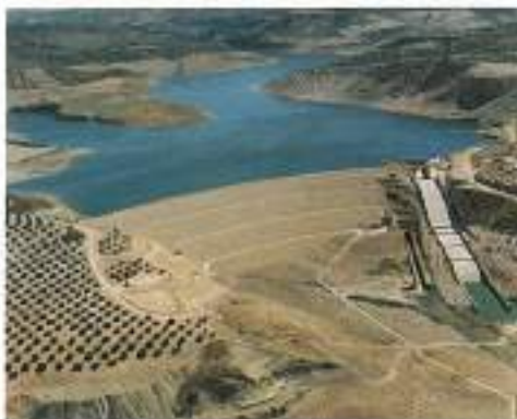
Presa de Vadomojón. Baena, Córdoba
