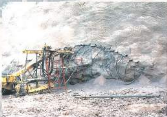
Línea AVE Madrid-Zaragoza, tramo Calatayud-Ricla. Control de ejecución del paraguas con micropilotes en la boca norte del túnel "Saviñán".
