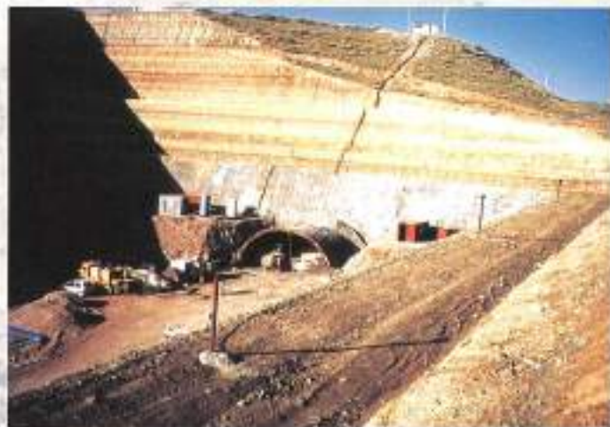
Línea AVE Zaragoza-Lérida. Entronque túnel "Las Hechiceras", lado Zaragoza.
