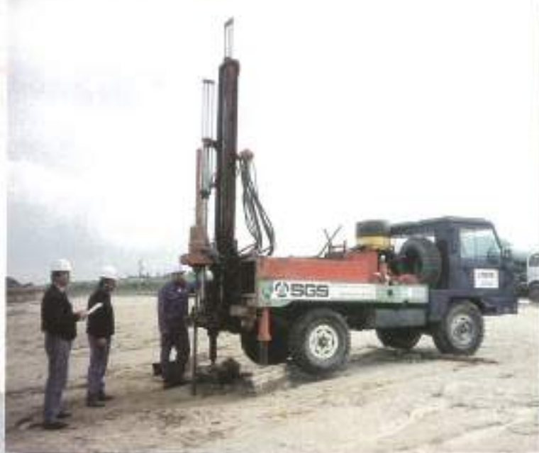
Maquinaria de sondeo especializada en geotecnia.
