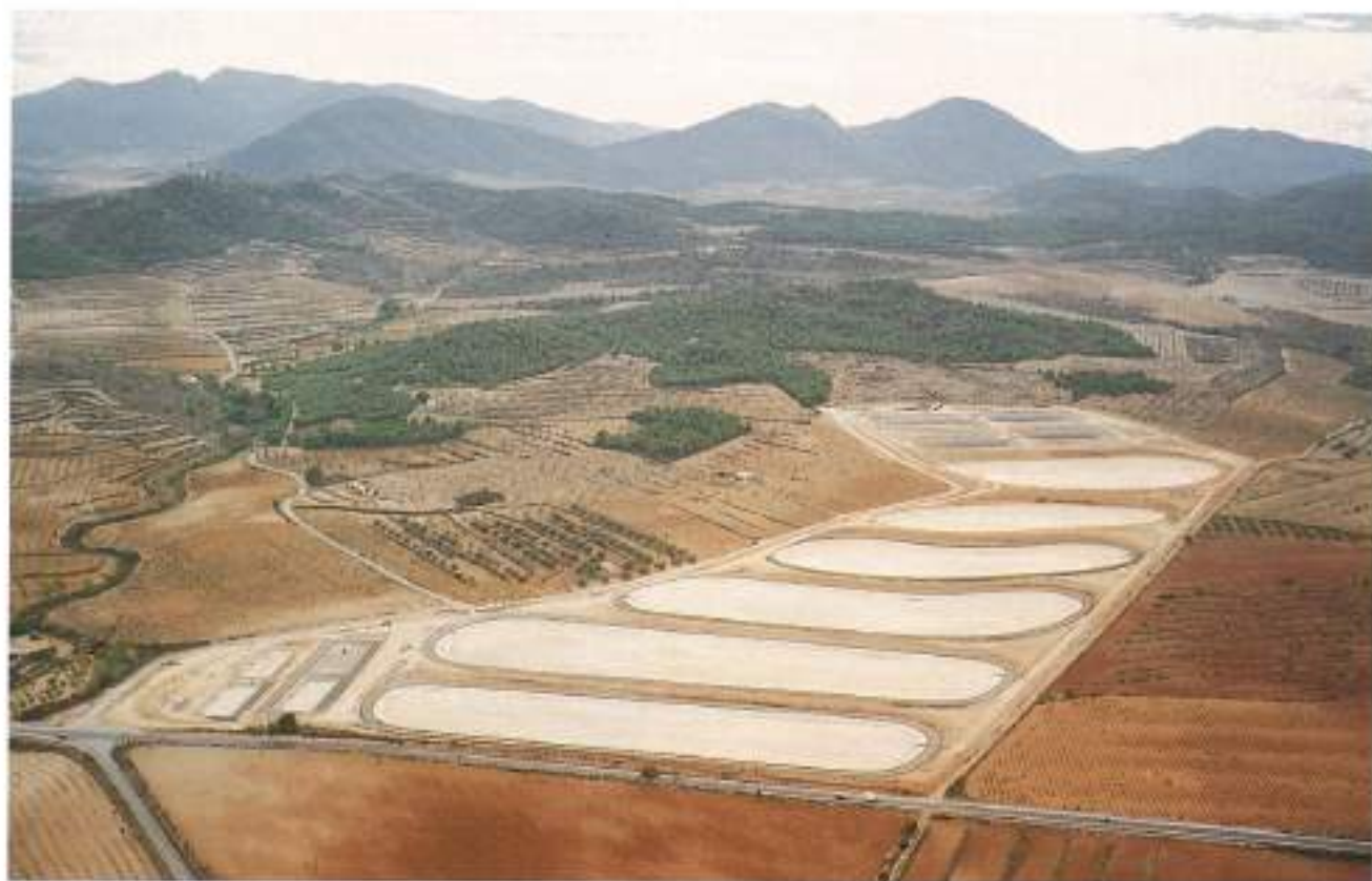
Depuradora de aguas residuales Bules MURCIA 120.000 m 2 (impermeabilizada con lámina DRAYFIL Embalses)
