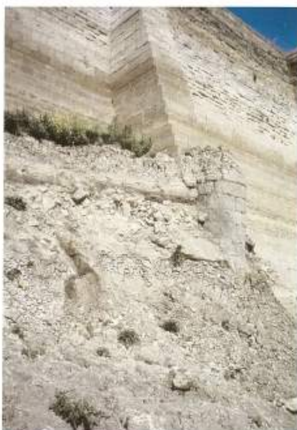
FIGURA 2. Corta del sedimento en el perfil PRO1.
