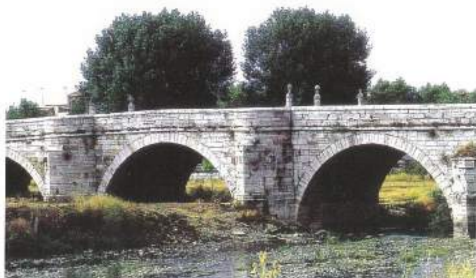
FOTO 2. Puente de Castro.
