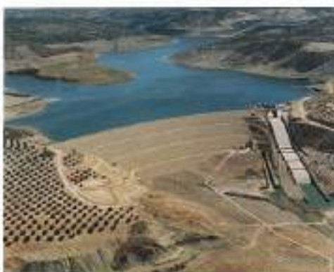
Presa de Vadomojón. Baena, Córdoba
