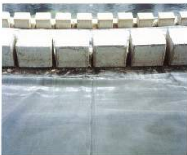
FIGURA 6. Embalse de Valle de San Lorenzo. Zona de unión entre paños en la geomembrana de PEAD situada en la parte norte del área de coronación.
