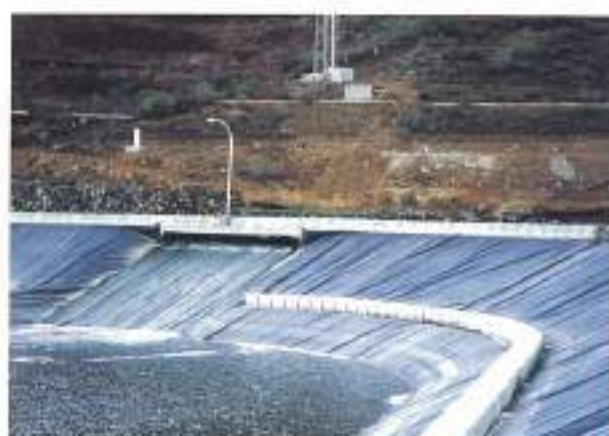
FIGURA 4. Vista de la entrada de agua al embalse de Valle de San Lorenzo procedente de la depuración de las aguas residuales de Santa Cruz de Tenerife.
