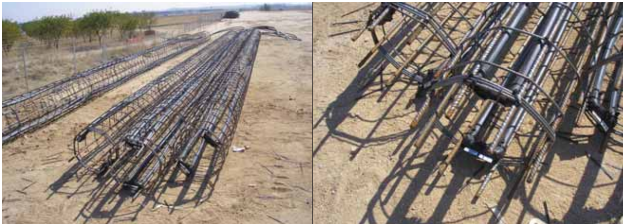
FIGURA 1. Detalle de la fijación de las sondas geotérmicas a la armadura del pilote.
