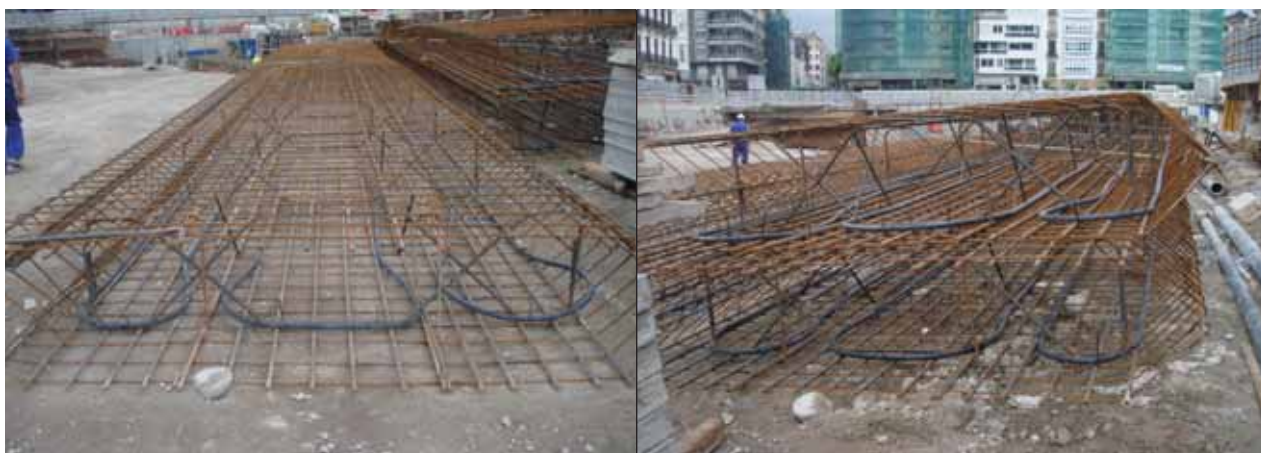
FIGURA 12. Detalle del colector geotérmico fijado a la armadura de la pantalla.
