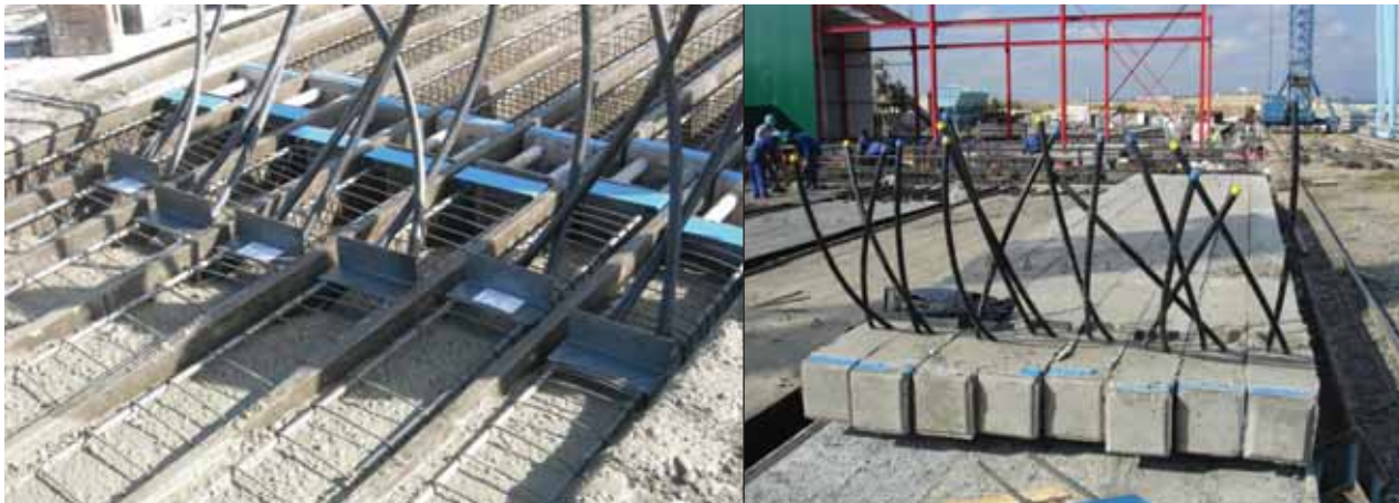
FIGURA 4. Detalle de la fabricación de los pilotes y los pilotes termoactivos almacenados fuera de los moldes.
