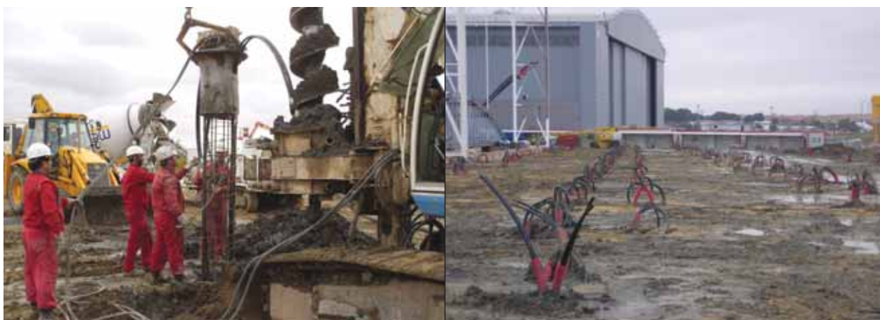
FIGURA 3. Colocación de la armadura del pilote termoactivo y pilotes termoactivos terminados.
