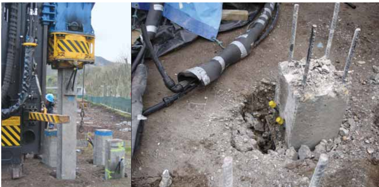
FIGURA 5. Hincada de los pilotes termoactivos y detalle de un pilote descabezado con las sondas geotérmicas.
