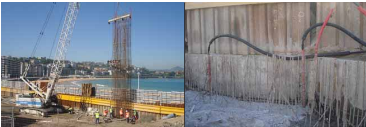
FIGURA 14. Colocación de la armadura de la pantalla y pantalla termoactiva terminada.
