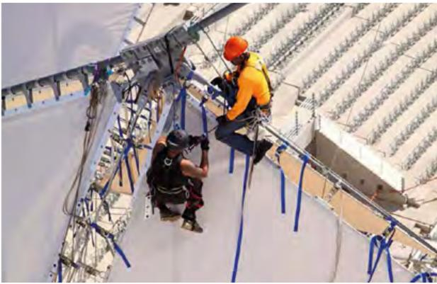
Figura 23. Colocación membrana cubierta.
