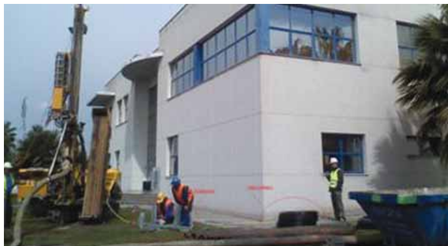
FIGURA 10. Ejecución del intercambiador de calor enterrado en la planta de Cemex de Albuixech.
