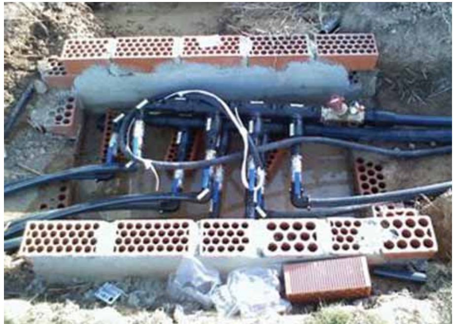
FIGURA 11. Ejecución de una arqueta para la instalación de sensores de temperatura.
