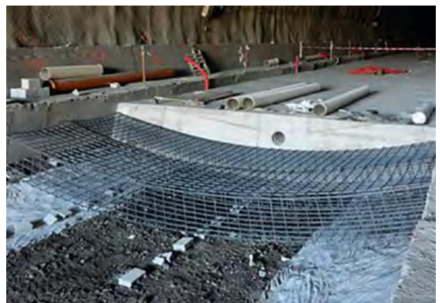
Foto 22. Ejecución de contrabóveda.
