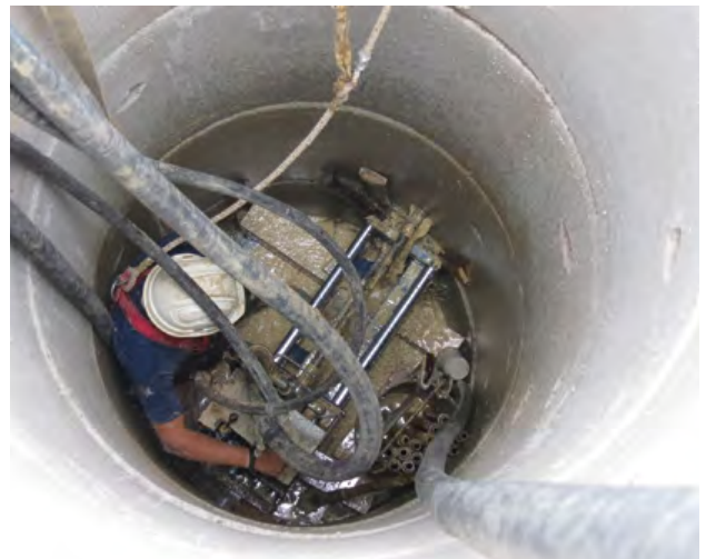
Foto 3. Ejecución de tubos de comunicación entre pozos y de drenes radiales desde un pozo.
