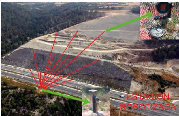
Foto 20. Control topográfico de movimientos..
