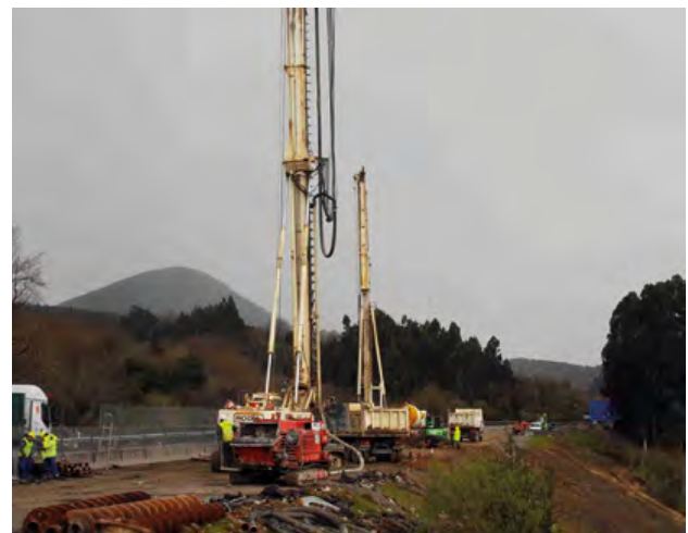
Foto 9. Ejecución de las columnas de mortero.
