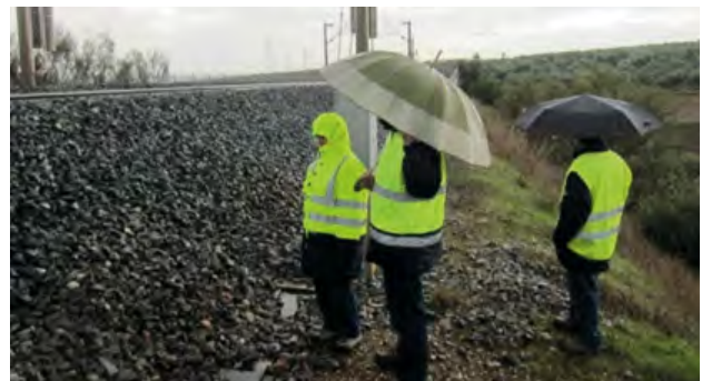
Foto 26. Sección instrumentada con espesor importante de balasto.
