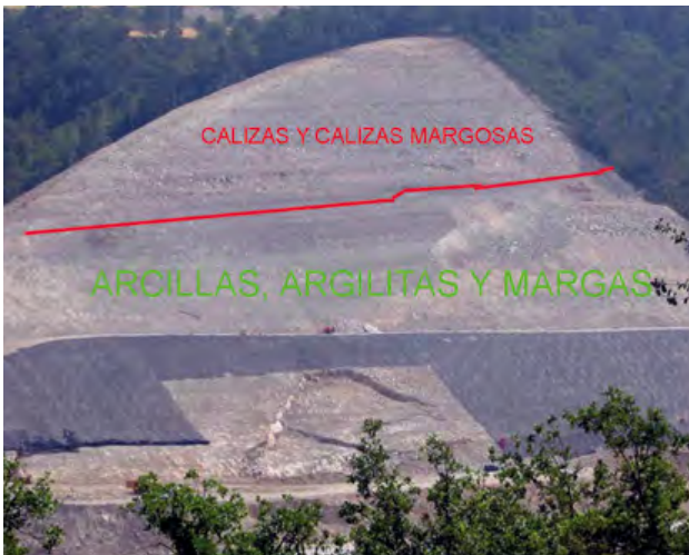
Foto 11. Desmonte durante su construcción.
