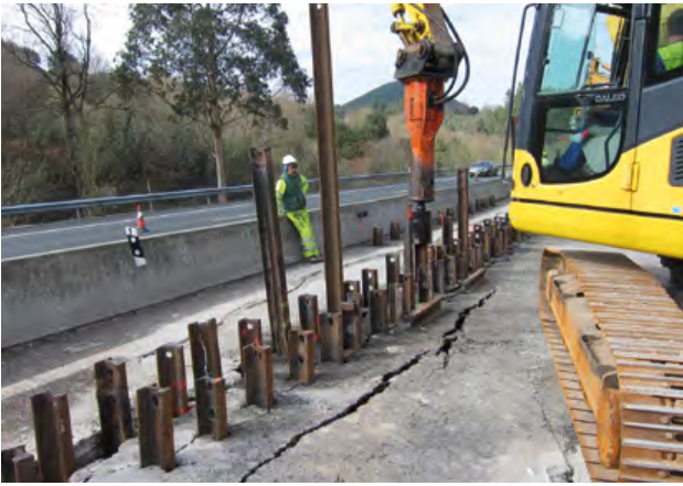
Foto 7. Hinca de carriles.
