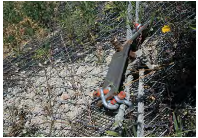
Foto 18. Sujeción de la cabeza de los bulones.
