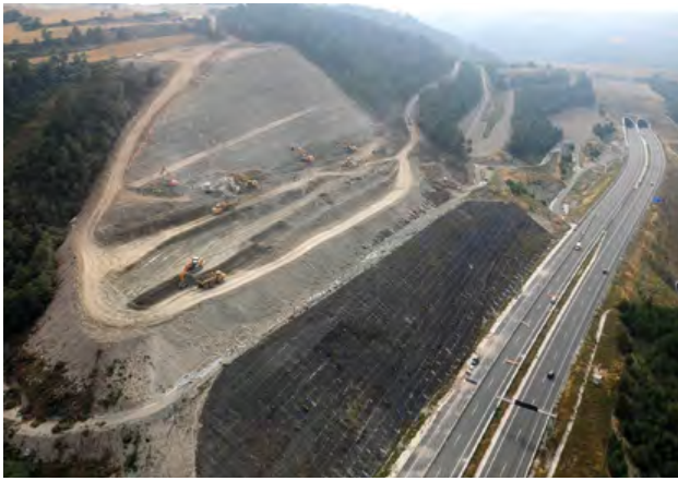
Foto 19. Ejecución de las obras.
