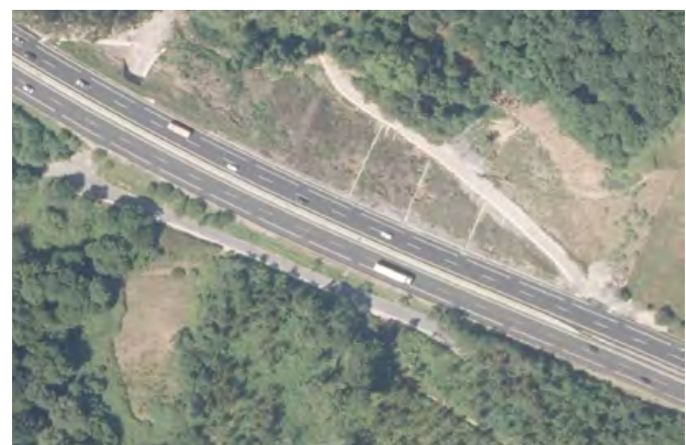
Foto 10. Vista de la obra finalizada.
