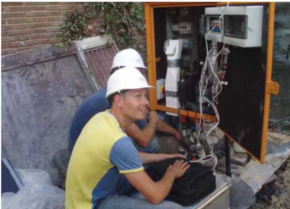
FIGURA 2. Realización de TRT en el centro de Madrid por técnicos de Geoter. (Fuente: Geoter).
