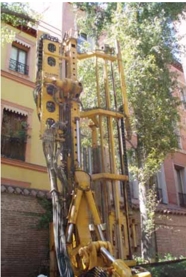
FIGURA 5. Equipo de perforación específico para geotermia. (Fuente: Geoter).
