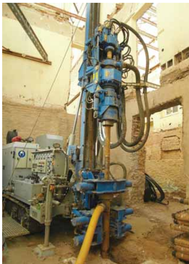
FIGURA 6. Perforación a rotación con circulación directa de lodos en un edificio en rehabilitación en Madrid. Fuente: Eneres.
