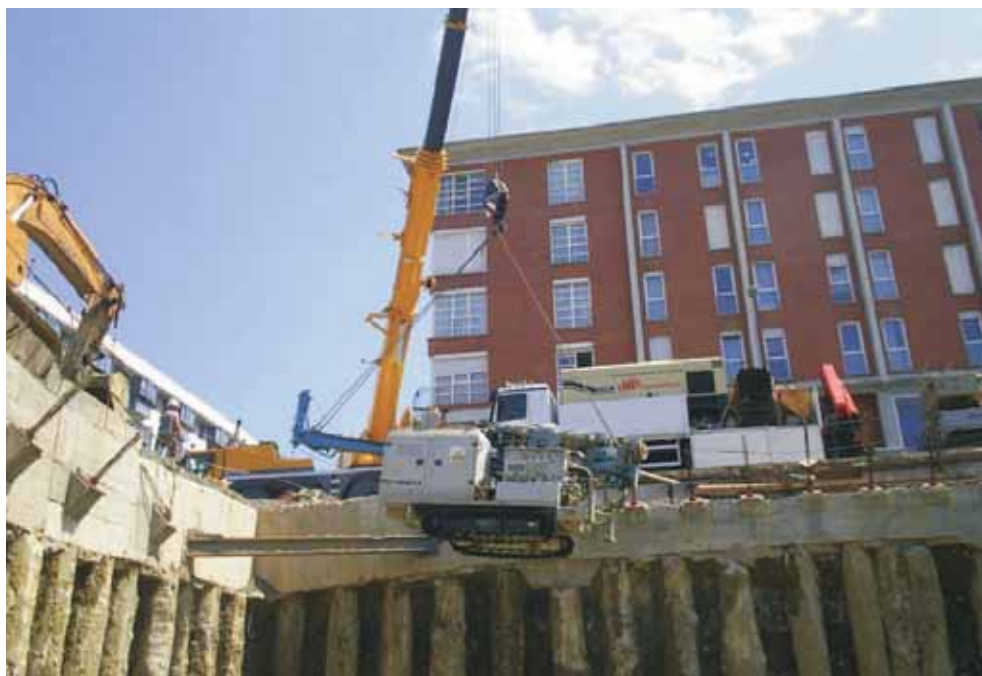
FIGURA 7. Descenso de una perforadora a una excavación. Fuente: Termoterra.
