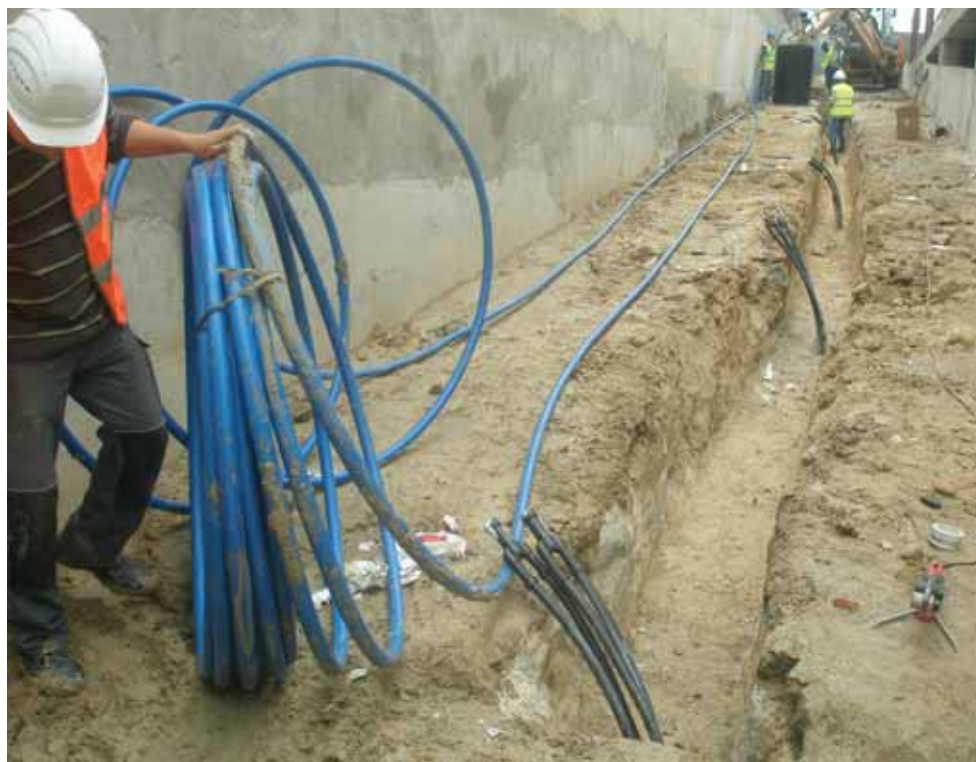
FIGURA 4. Tendido de colectores para conectar siete sondas geotérmicas dobles en una nave industrial en Colmenar Viejo (Madrid). Fuente: Geoter.
