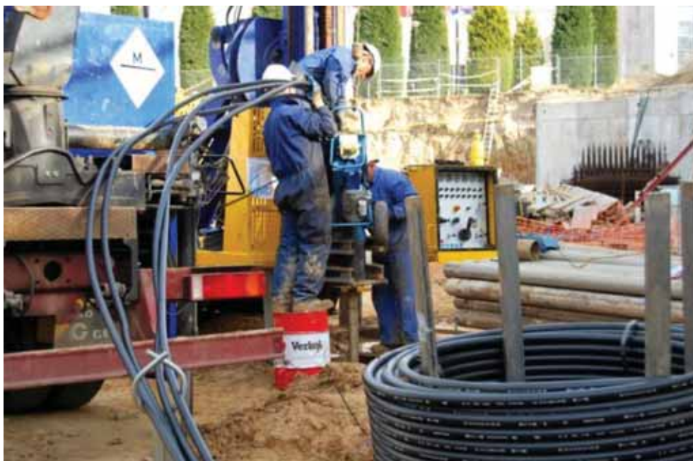
FIGURA 10. Introducción de una sonda geotérmica doble con un slangman. Fuente: EDASU.
