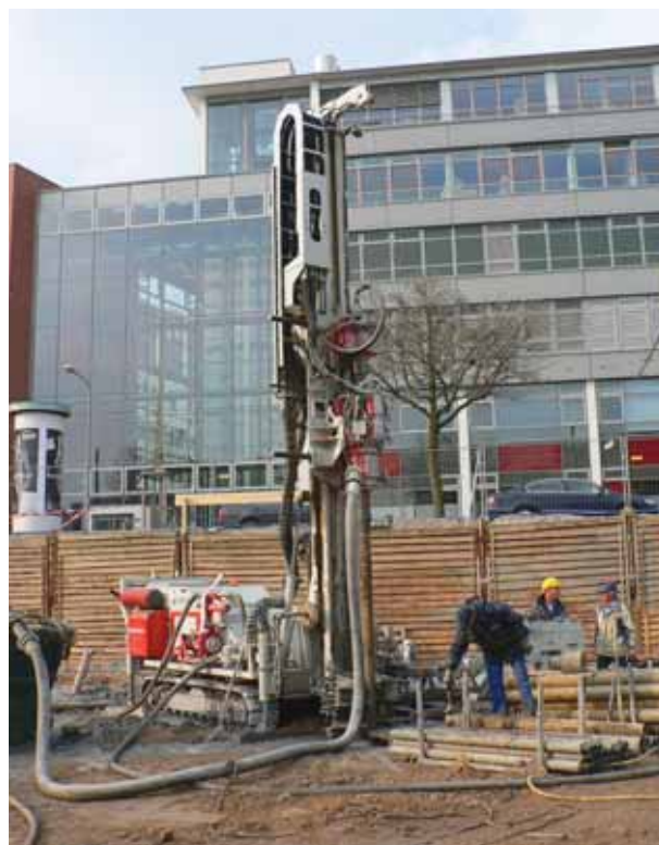
FIGURA 8. Perforadora con doble unidad de rotación y manguera para descarga de detritos en un contenedor. Fuente: Comacchio.
