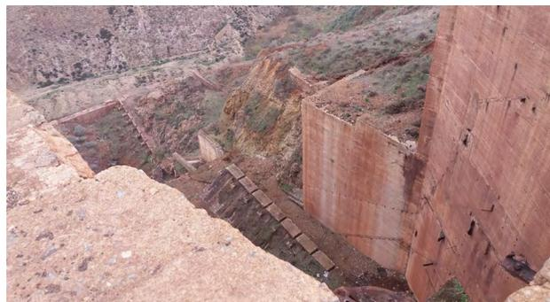
**Figura 12.** Estructura de hormigón en la que se alojaba el tren de machaqueo.
