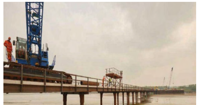
Figura 3. Vista construcción puente provisional.
