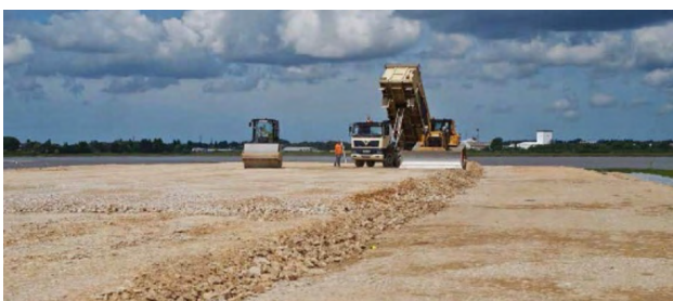
Figura 2. Ejecución caminos de acceso provisional.
