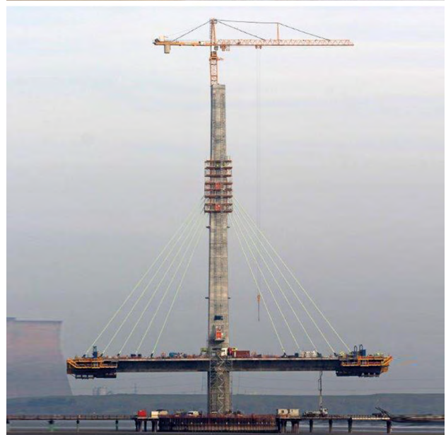
Figura 12. Distintas perspectivas de construcción de tablero del puente.
