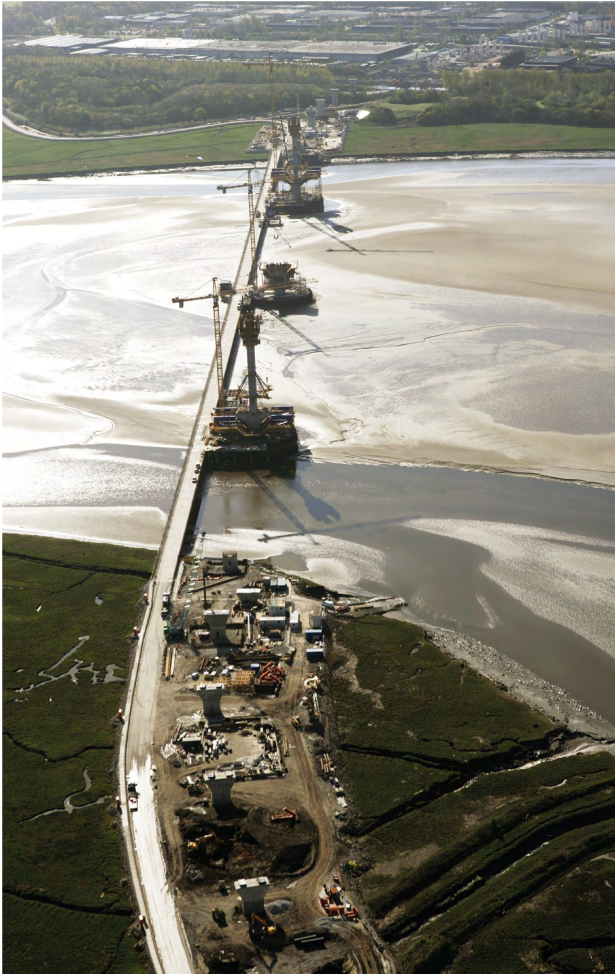
Figura 13. Diferentes actividades en ejecución de forma simultánea en la obra.
