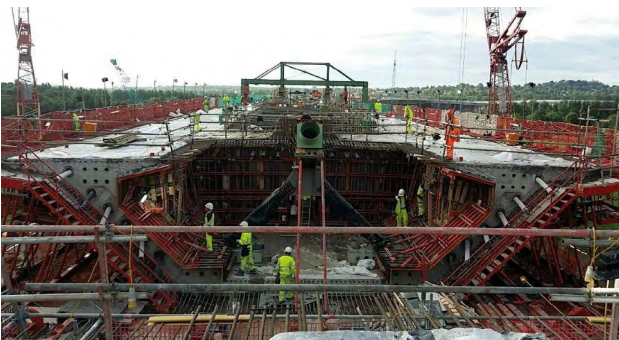
Figura 8. Vista de montaje de estructura.
