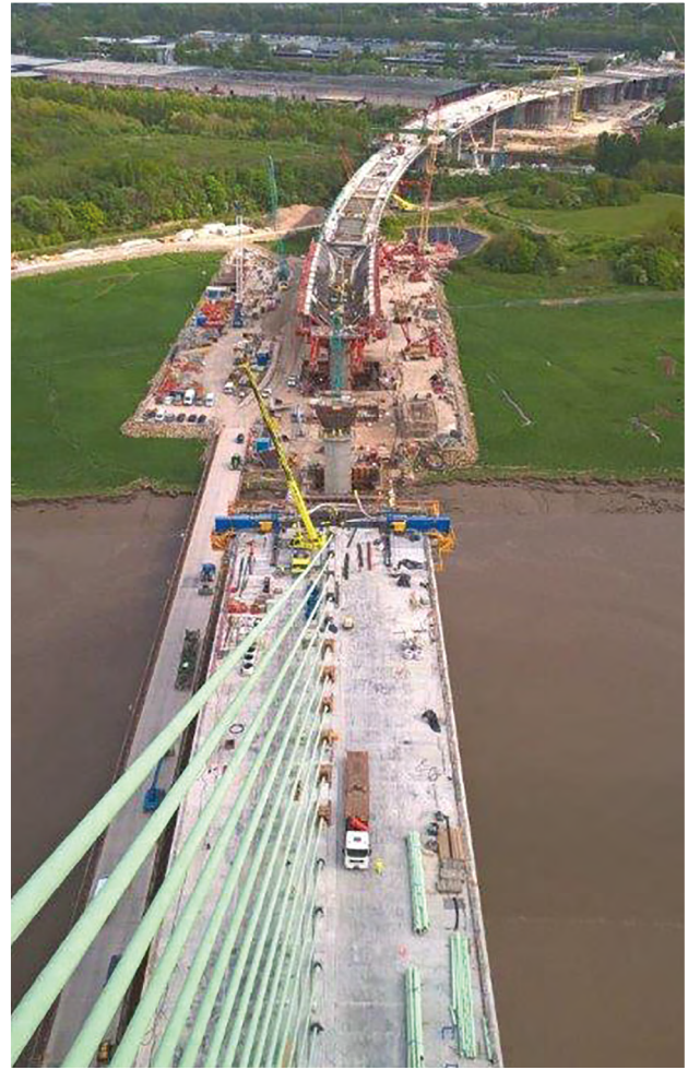
Figura 15. Viaducto de aproximación Sur.
