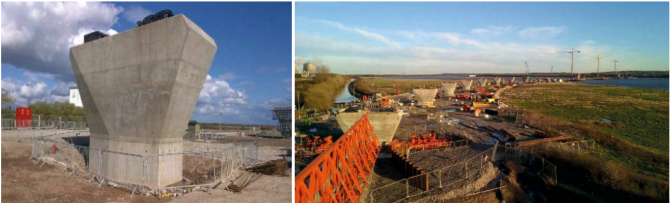
Figura 6. Ejecución pilas en viaductos de aproximación. La pila más alta es de 31,86 metros, en el acceso sur.
