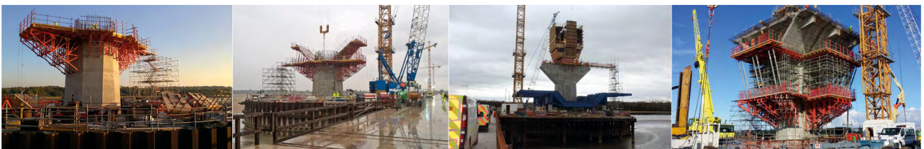
Figura 11. Perspectiva pilas metálicas.
