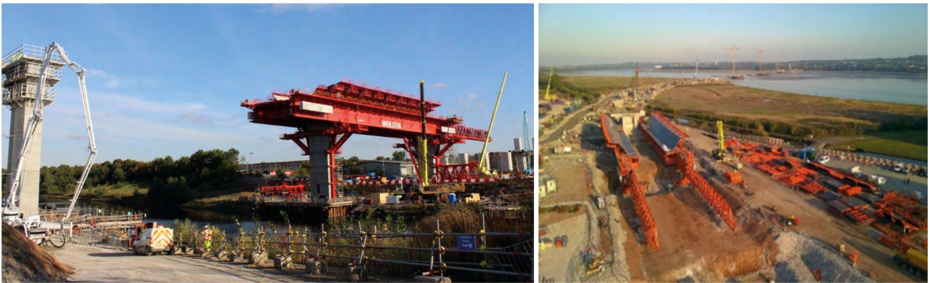
Figura 7. MSS viaductos aproximación Norte y Sur.
