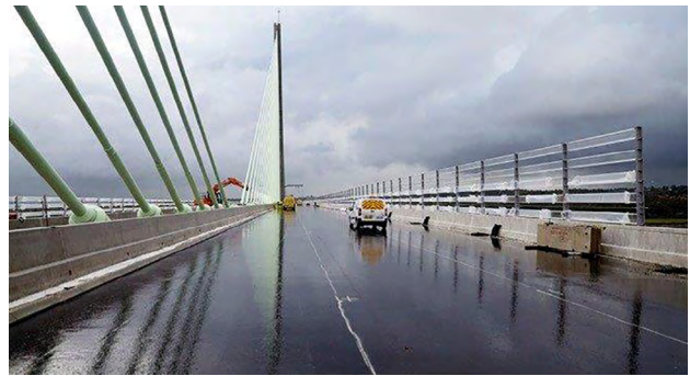
Figura 16. Ejecución de acabados: impostas, barreras, instalaciones eléctricas, comunicaciones, barreras anti-viento, pavimentos y señalización.
