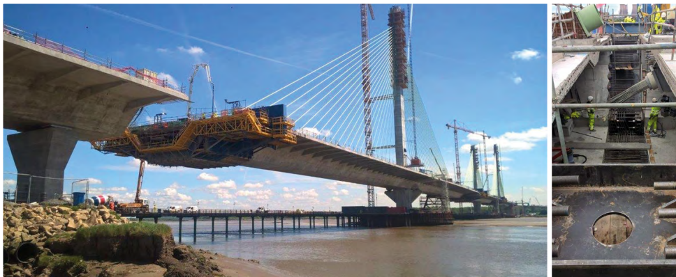
Figura 14. Carro en voladizo (Vano Pilono Norte-Viaducto aproximación Norte). Segmento de cierre.
