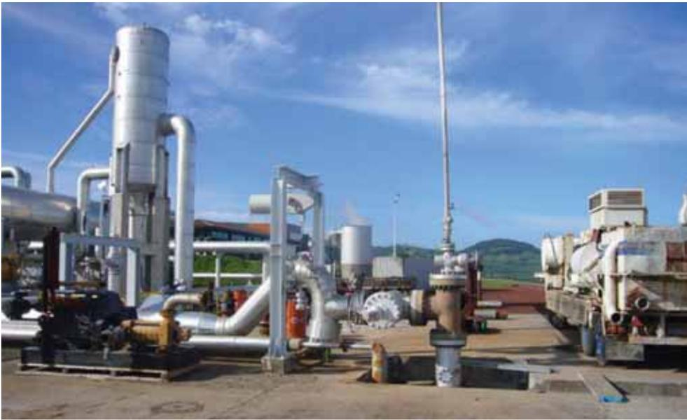
**FIGURA 7.** Sondeo geotérmico (alta temperatura) y separador de fluido.
