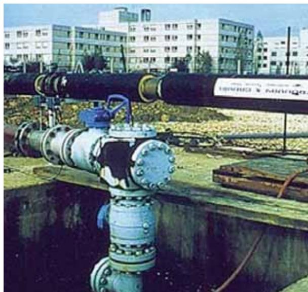
FIGURA 9. Sondeo geotérmico profundo de baja temperatura suministrando calefacción de distrito.
