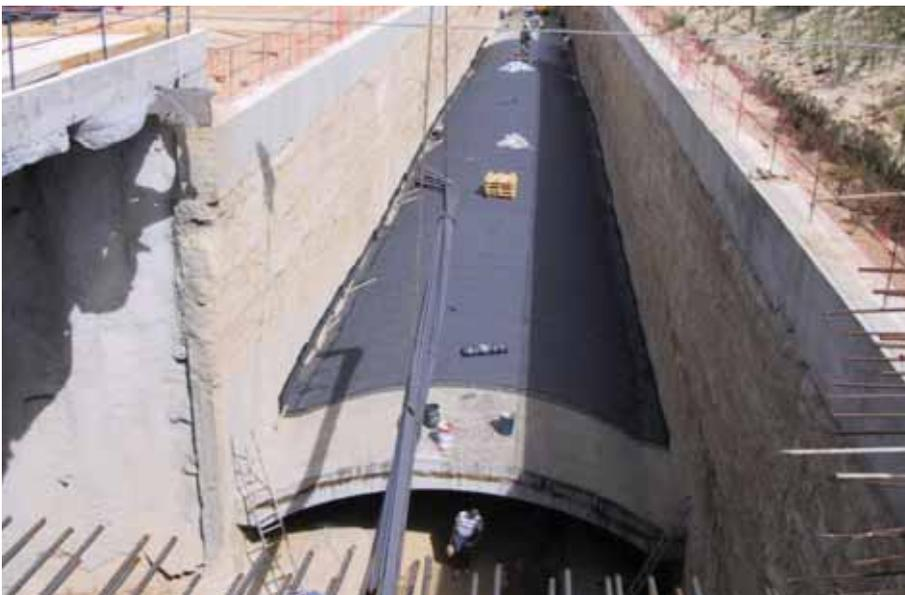
FIGURA 19. Ejecución de bóveda de túnel desde superficie.
