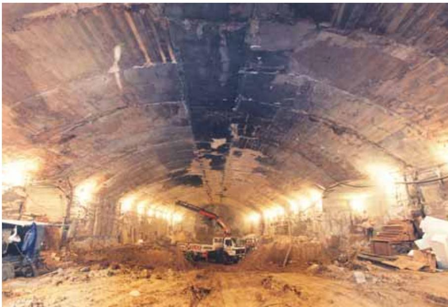
FIGURA 12. Estación subterránea ejecutada mediante método Alemán.
