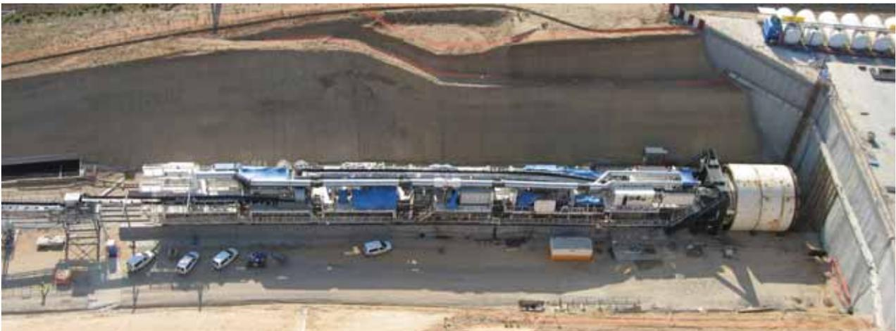
FIGURA 37. Montaje de tuneladora EPB con back-up.
