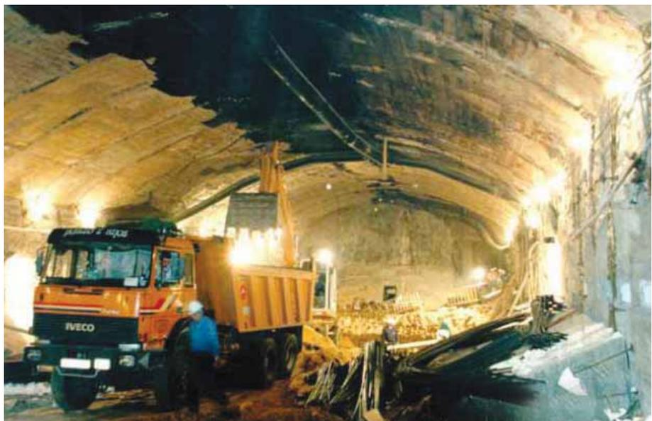
FIGURA 15. Excavación de la caverna (Estación de Guzmán el Bueno).
