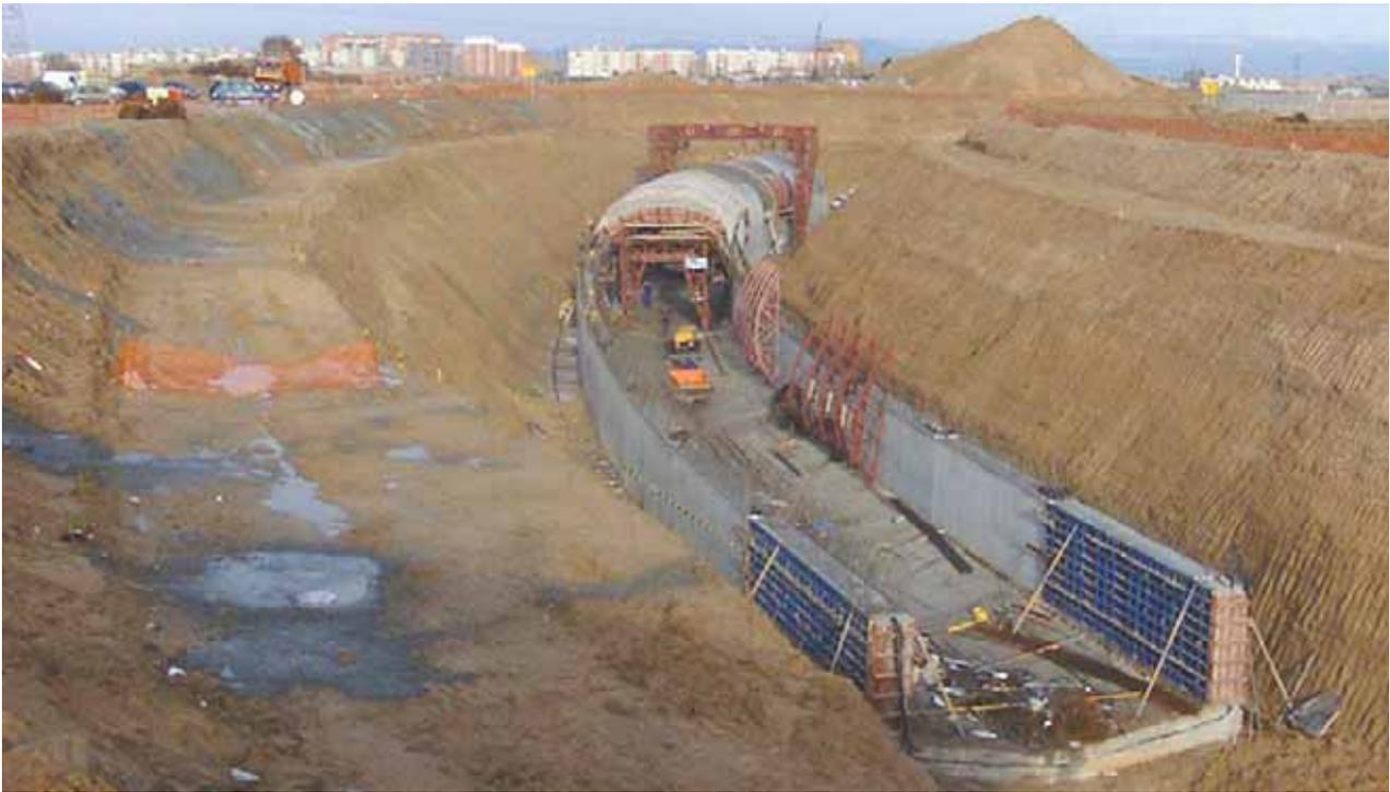
FIGURA 23. Ejecución de túnel a cielo abierto en trinchera.
