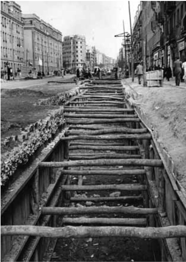
FIGURA 18. Ejecución de un muro lateral de túnel desde superficie.
