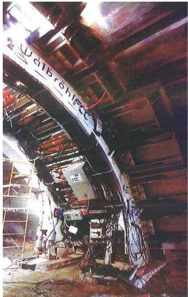
FIGURA 28. Entibadora de lanzas (FCC, Acceso ferroviario a Alcobendas).
