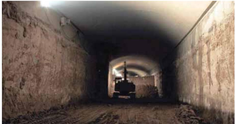
FIGURA 20. Excavación interior bajo bóveda.
