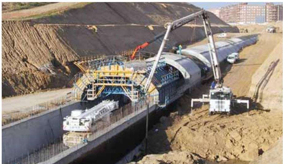
FIGURA 24. Ejecución de túnel a cielo abierto en trinchera.
