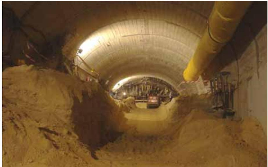
**FIGURA 10.** Excavación de destroza central.
