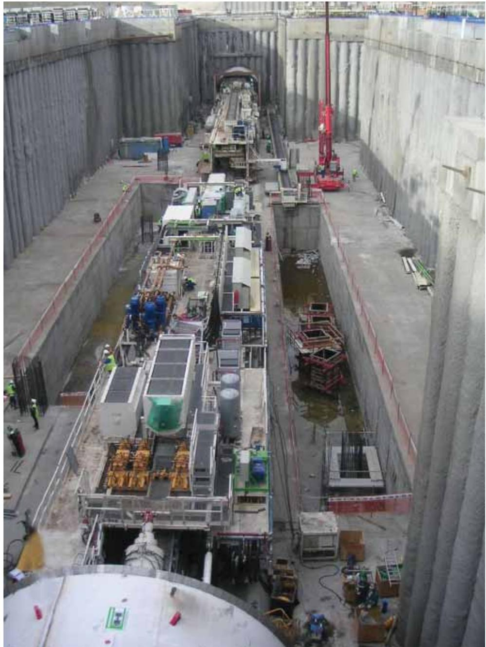
**FIGURA 35.** Estación utilizada como pozo de ataque de 2 tuneladoras EPB.
