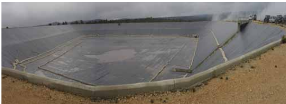
FIGURA 3. Balsa de Calderones (Valencia) impermeabilizada con PEAD.
