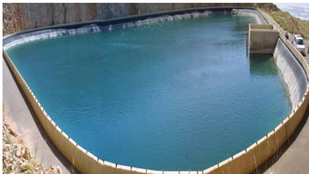
FIGURA 4. Balsa del Cerrillo del Libro (Almería) impermeabilizada con PEMBD.
