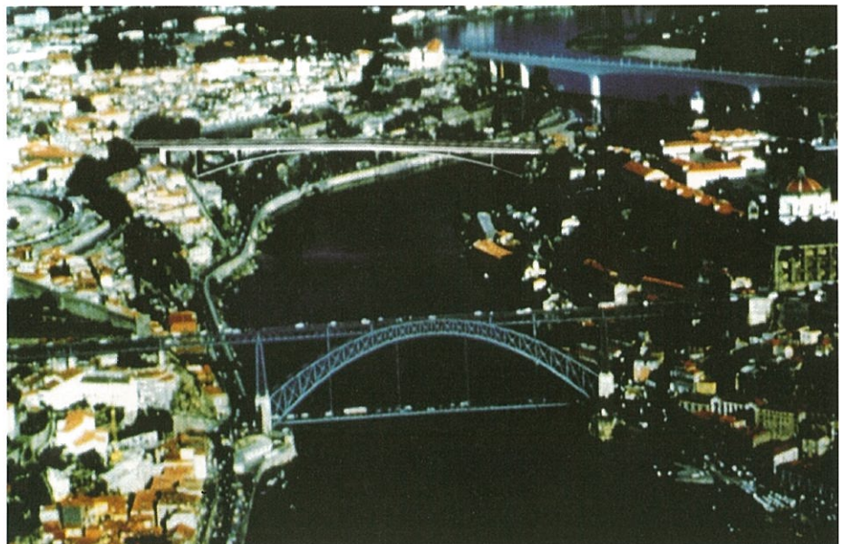
Vista aérea de los puentes Luiz I, Infante D. Henrique, D. Maria y S. João.
