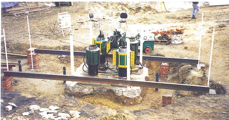
FIGURA 5. Disposición de los ensayos de carga especiales efectuados por el Laboratorio de Geotecnia del CEDEX para determinar el grado de mejora en suelos margosos después de realizar inyecciones por fracturación hidráulica.
