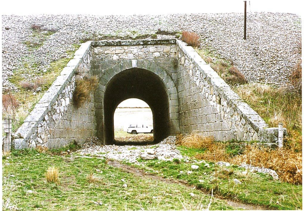
Puente Rvilleja. Línea Madrid-Hendaya.
