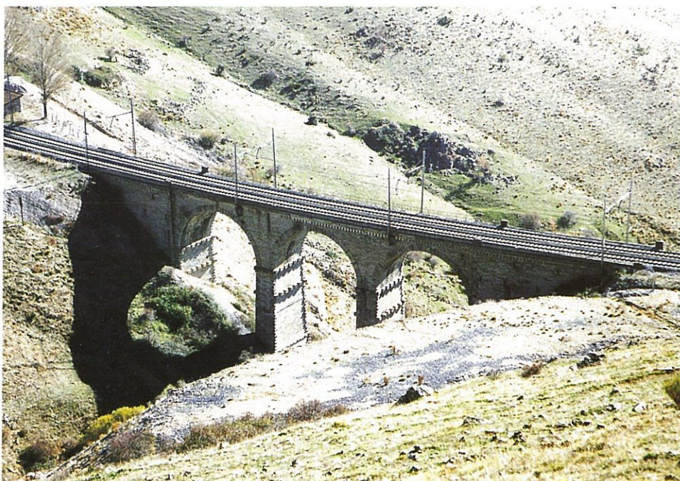
Puente Valdespino. Línea Madrid-Hendaya.
