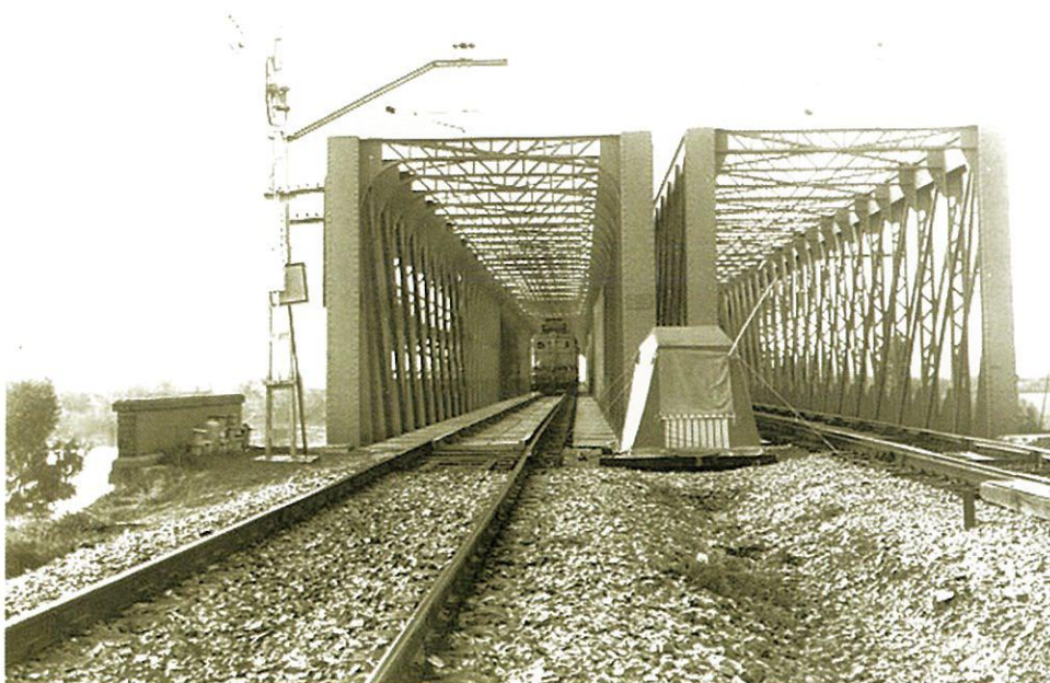
Puente sobre el río Guadalquivir. Línea Alcázar-Sevilla.
