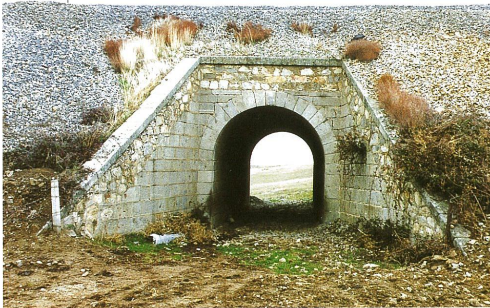
Puente Rvilleja. Línea Madrid-Hendaya.
