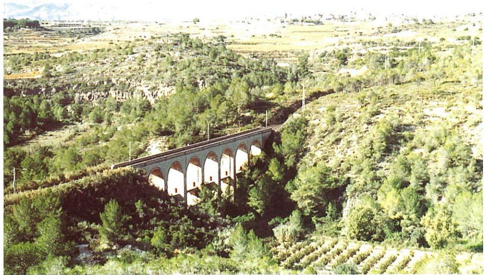
Puente Río Gaia. Línea La Plana-Roda de Bará (Tarragona).
