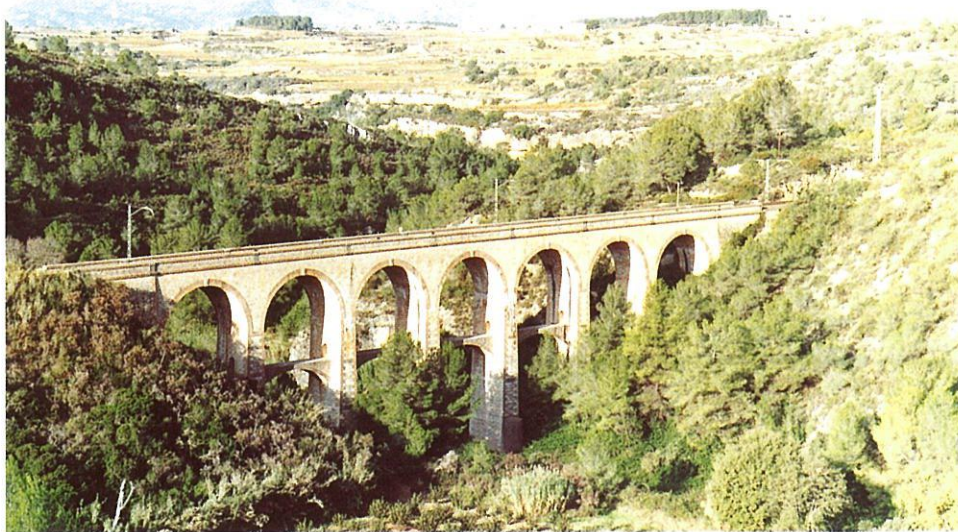
Puente Río Gaia. Línea La Plana-Roda de Bará (Tarragona).
