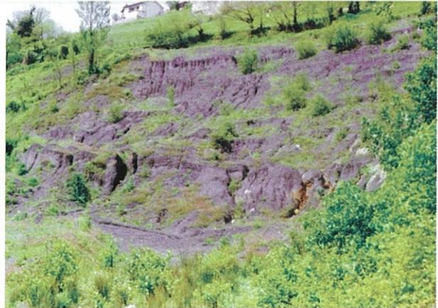
FIGURA 1. Deslizamiento de una escombrera en las proximidades de Olloniego.
