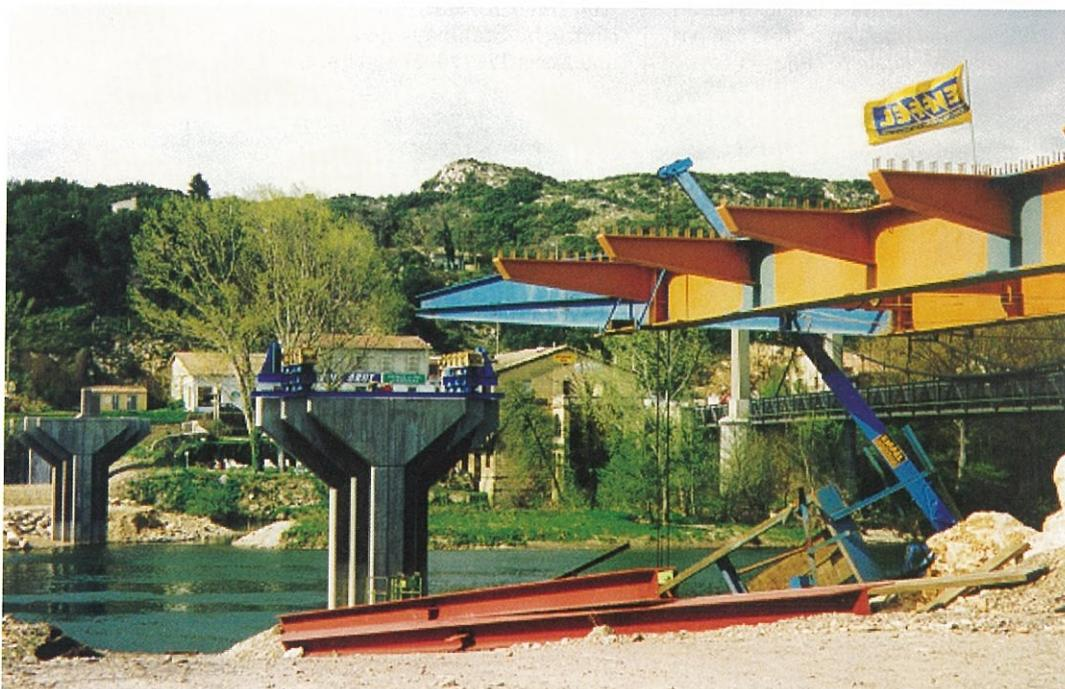
**FIGURA 7.** Puente de carreteras cerca de Réroulins (F). Vigas longitudinales en S460ML.
