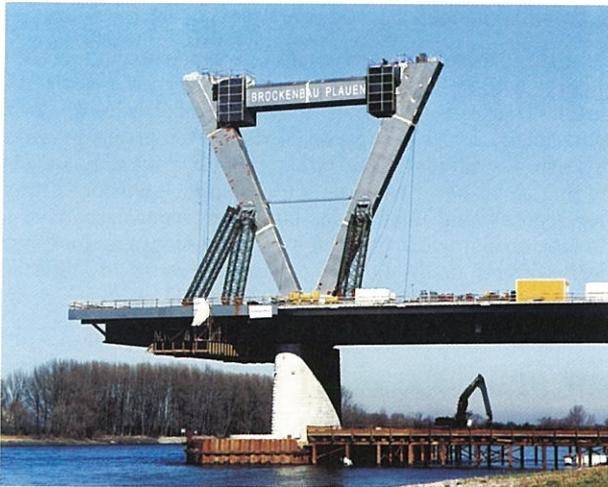
**FIGURA 6.** Pilar durante la construcción del futuro puente Ilverich que cruza el Rin cerca de Düsseldorf (Alemania). Lo alto del pilar es fabricado con S460ML en espesores hasta 100 mm.
