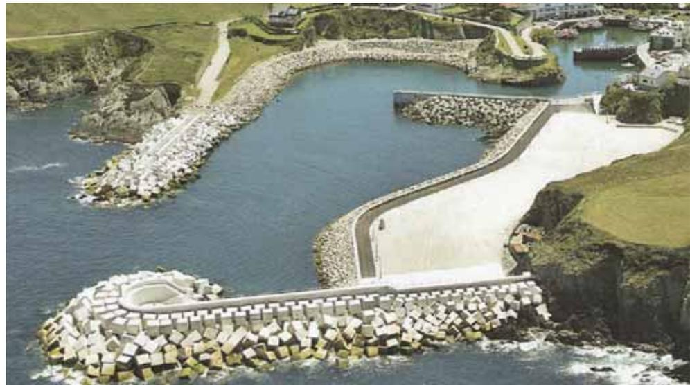
FIGURA 2. Ampliación del Dique de Puerto Vega, Asturias.
