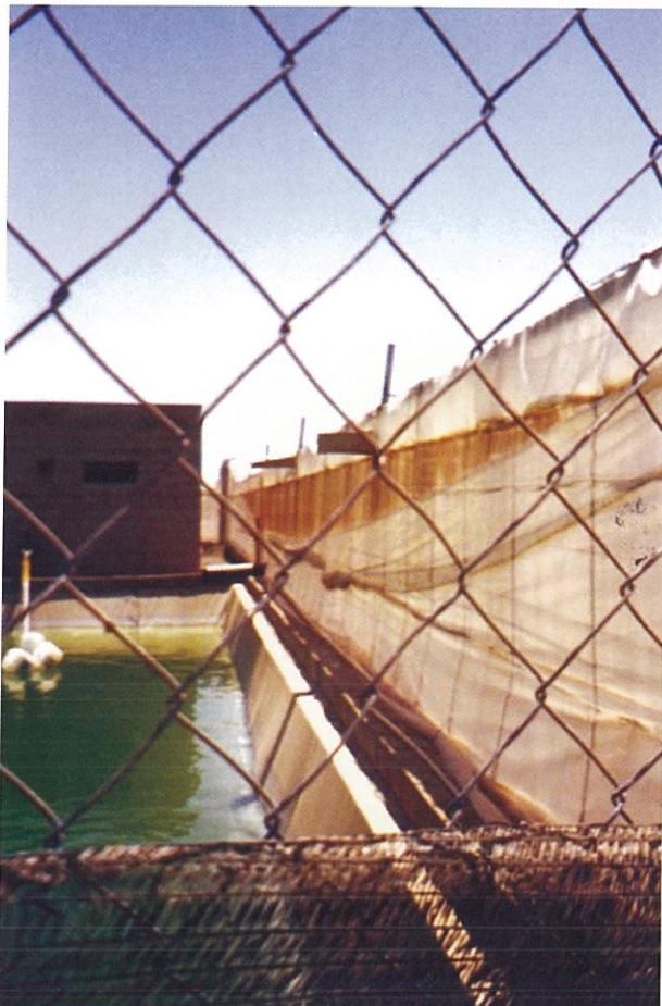
FOTO 2. Embalse vallado e impermeabilizado con cloruro de polivinilo en el que desembocan las canaletas de forma directa procedentes del invernadero.
