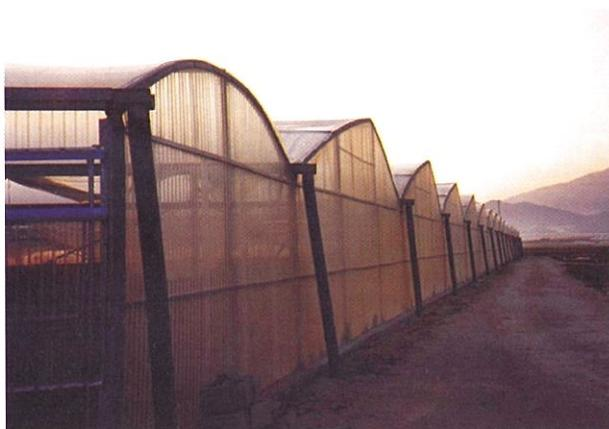
FOTO 1. Invernadero multicapilla, donde se observa la distribución de canaletas y tuberías de desagüe a lo largo de su perímetro.
