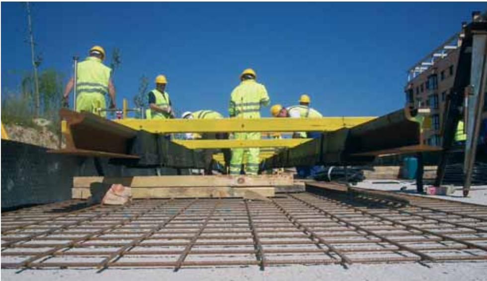
FIGURA 28. Montaje de pórticos de nivelación.
