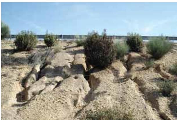
**FIGURA 45.** La vegetación leñosa por sí sola es incapaz de controlar la erosión, sin un estrato herbáceo. Pese al desarrollo en este talud de jaras y retamas, los daños erosivos son evidentes. Debería haberse realizado una hidrosiembra previa.
