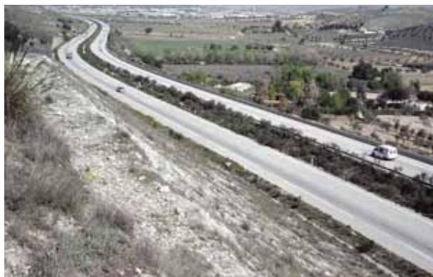
FIGURA 4. La existencia de sustratos desfavorables, como los yesíferos en este desmonte, condiciona el aprovechamiento de los materiales.
