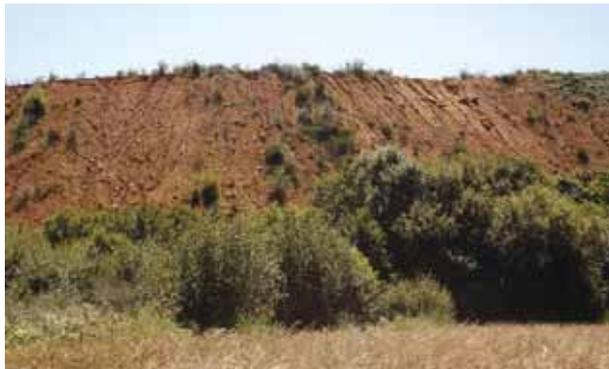
FIGURA 32. Vertedero de tierras mal planteado. El talud alcanza un arroyo; debería haberse respetado una mayor distancia entre el pie del talud y el cauce. Además, la superficie del terraplén está sin revegetar y los arrastres de tierras van directos al arroyo (Santiago de Compostela).
