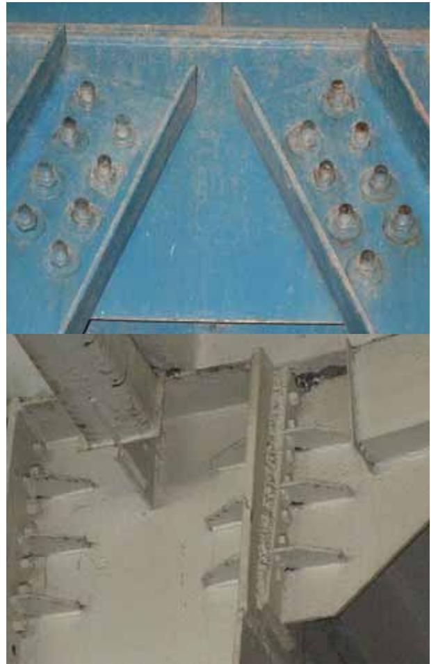
FIGURA 6. Uniones con pernos y elementos rigidizantes.
