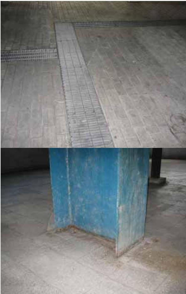
FIGURA 7. Diseño del sistema de drenaje y eliminación de derrames.
