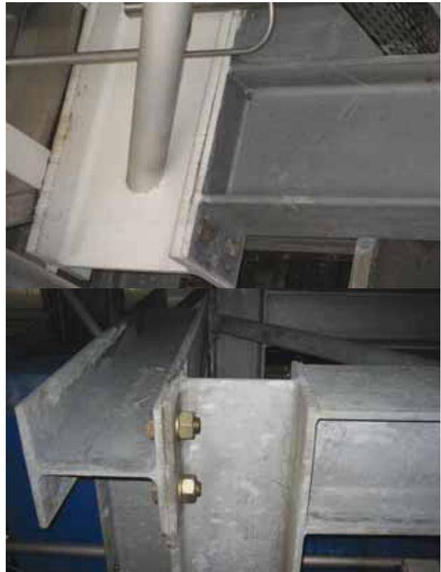
FIGURA 8. Uso de perfiles galvanizados.
