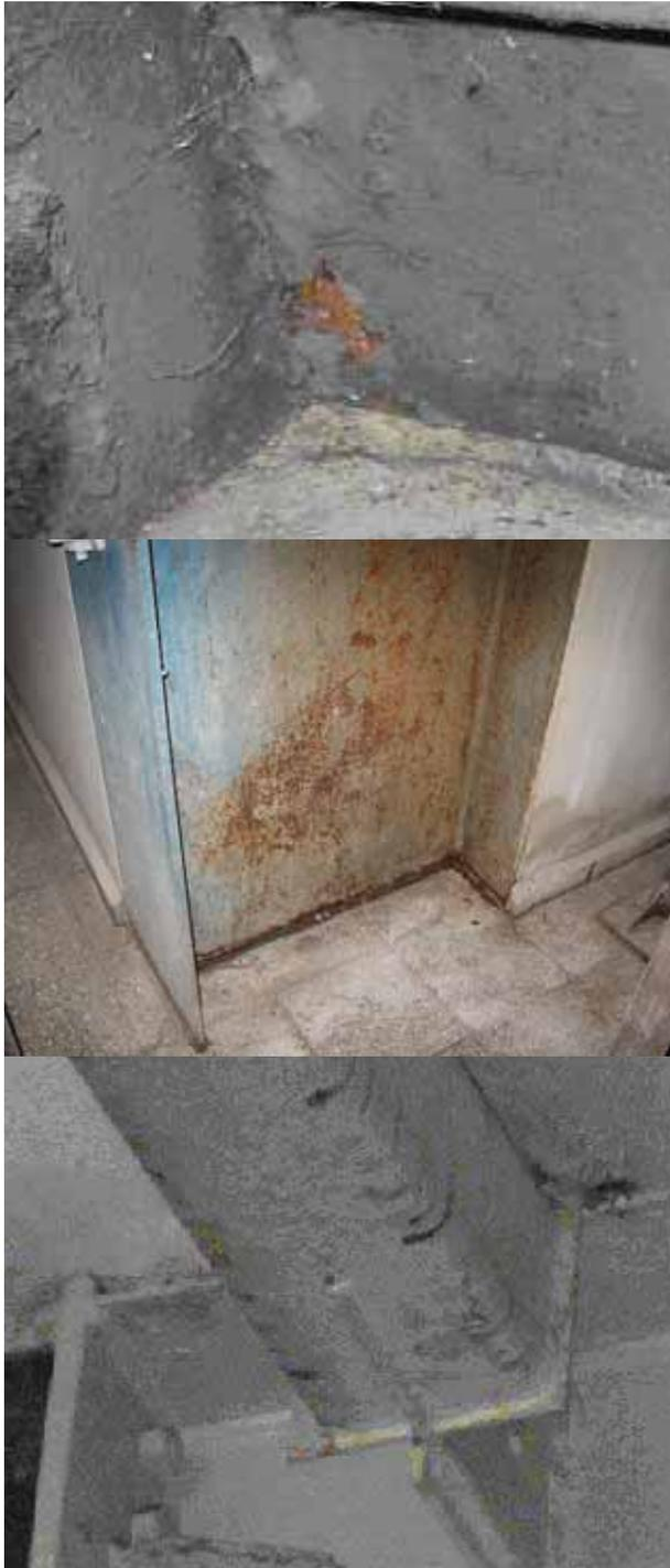
FIGURA 1. Deterioros de los sistemas de protección.
