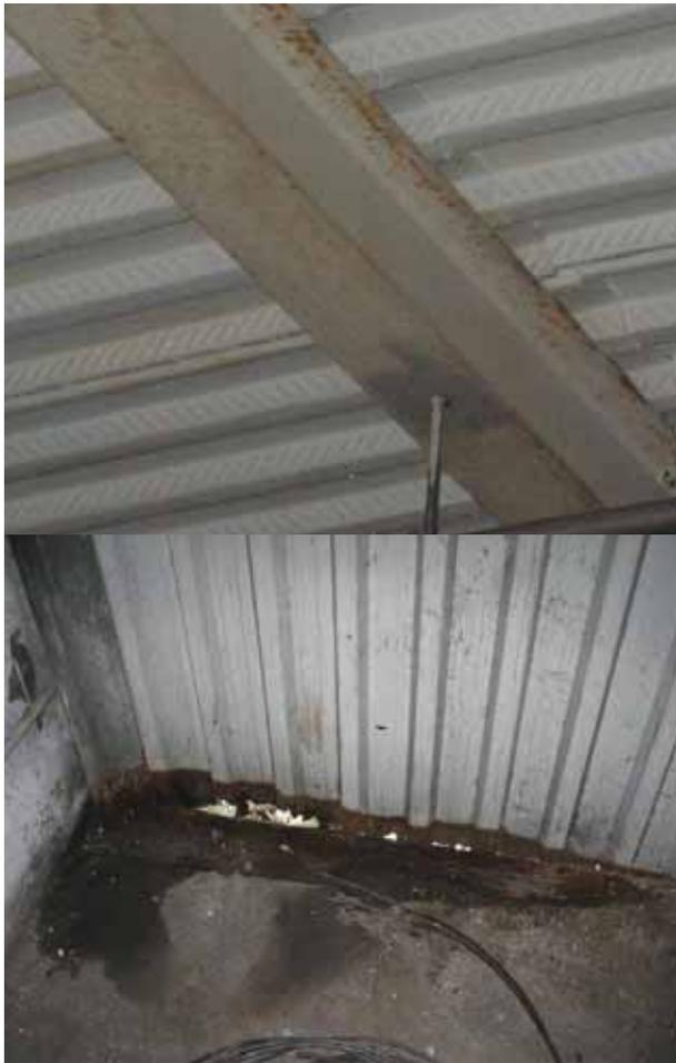
FIGURA 5. Uniones bimetálicas.
