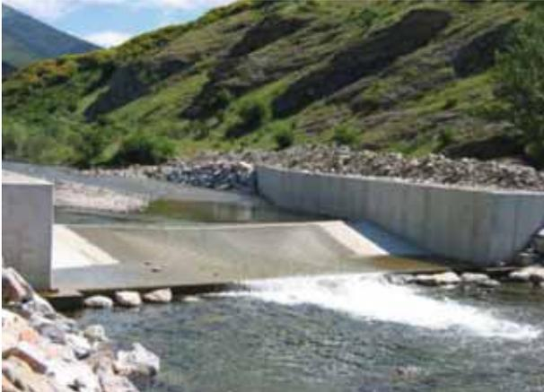
FIGURA 2. Ejemplo de estación de aforos de tipo V-flat donde son patentes muchos de los problemas descritos en el texto (río Carrión en Triollo, Palencia).
