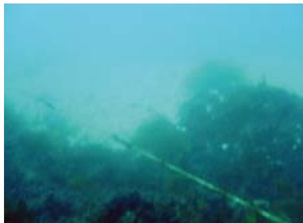
FIGURA 5. Replanteo del eje del emisario sobre el lecho marino.
