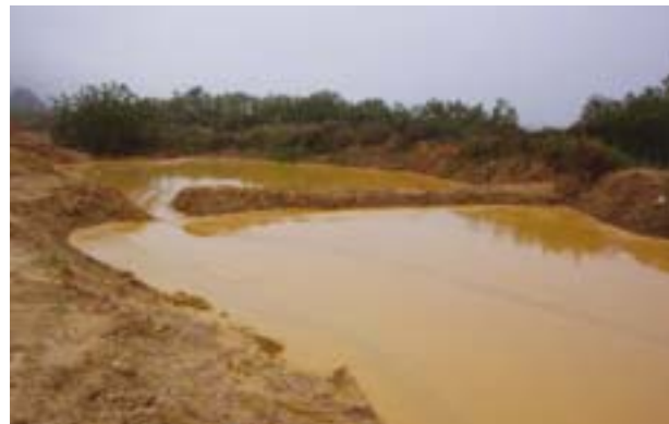
FIGURA 7. Circuitos de decantación instalados durante las labores de excavación de la cámara de carga.
