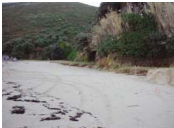
FIGURA 9. Situación previa de la duna tras la avería en la microtuneladora.
