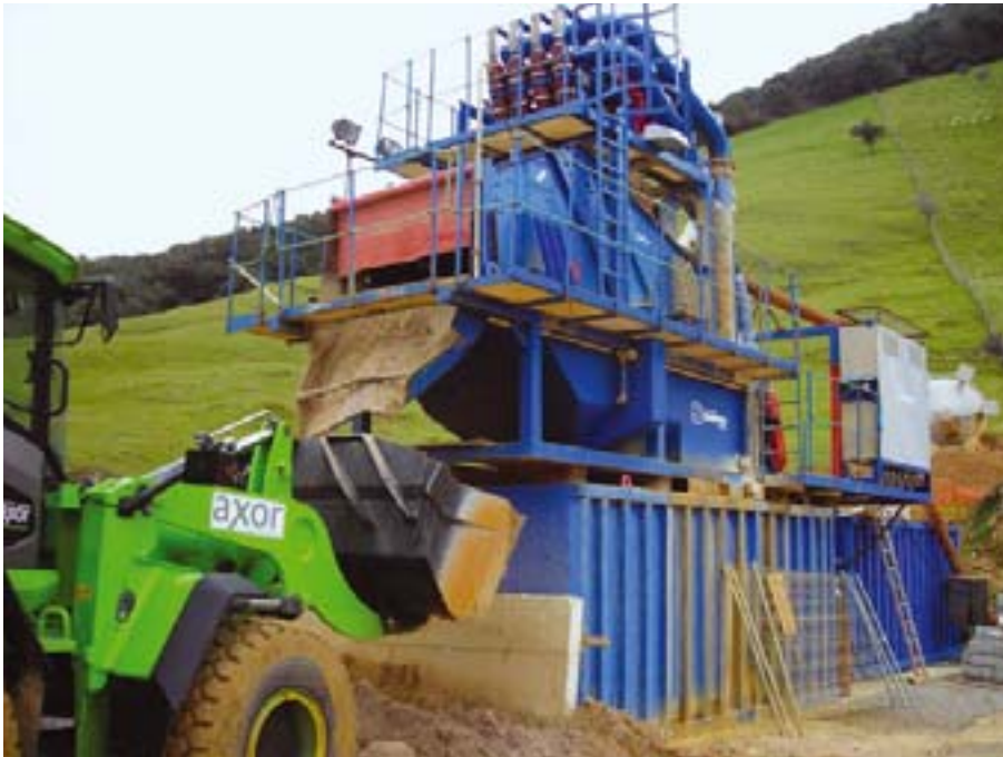
FIGURA 6. Dispositivos de desarenado y recirculación de las aguas empleadas en el frente de excavación.
