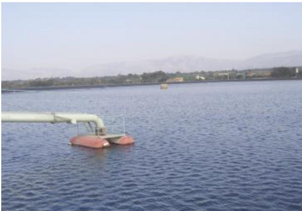
**FIGURA 3.** Toma de agua flotante.
