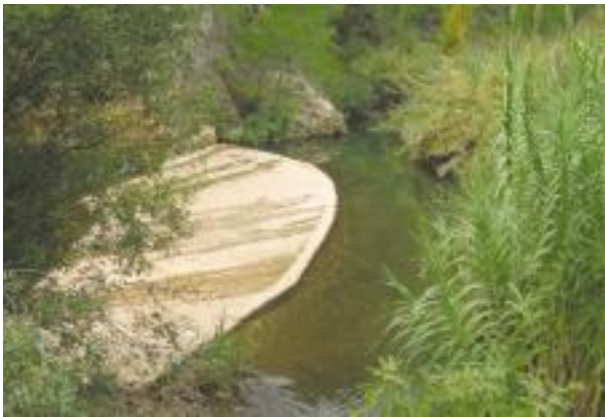
FIGURA 5. Azud colmatado y colonizado por un cañaveral. Río Mundo (Albacete).
