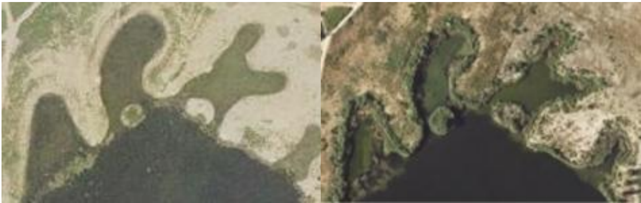
FIGURA 23. Colonización de la vegetación en las riberas de la laguna del Soto de las Juntas (Madrid), tras las excavaciones realizadas para su naturalización. Entre la fotografía izquierda y derecha han transcurrido cuatro años.
