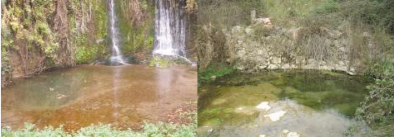
FIGURA 25. Pozas formadas al pie de dos azudes colmatados. Río Vinalopó (Alicante).
