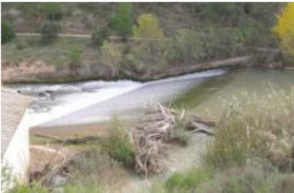
FIGURA 8. El azud genera un cambio drástico en la velocidad de las aguas. Río Mundo (Albacete).
