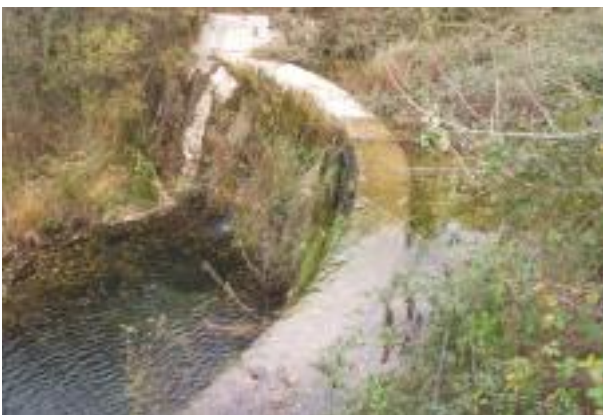
FIGURA 15. Los azudes son un obstáculo para los peces, que impiden su movimiento a lo largo del cauce.
