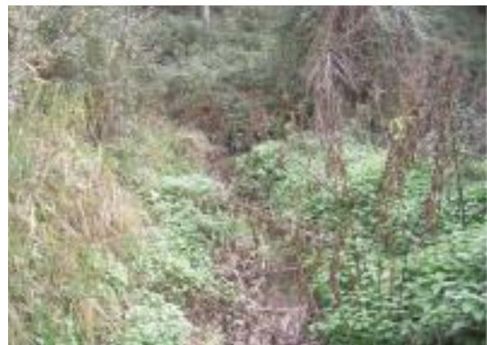
FIGURA 19. La colmatación del azud ha llevado a la desaparición de la zona de inundación, colonizada por vegetación, quedando un cauce colgado sobre el azud.
