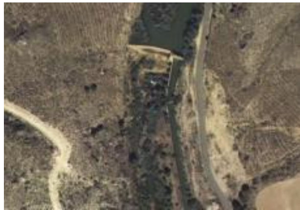
FIGURA 27. Detracción excesiva de caudales. El canal lateral deriva agua en toda su capacidad, mientras el río tiene un caudal escaso aguas abajo del azud.
