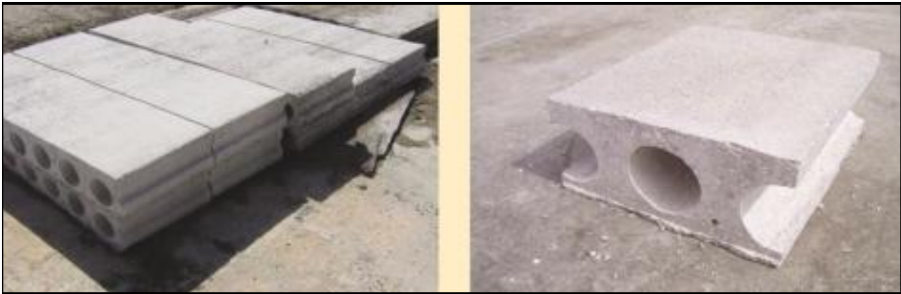
FIGURA 3. Cortes de piezas de losas prefabricadas.
