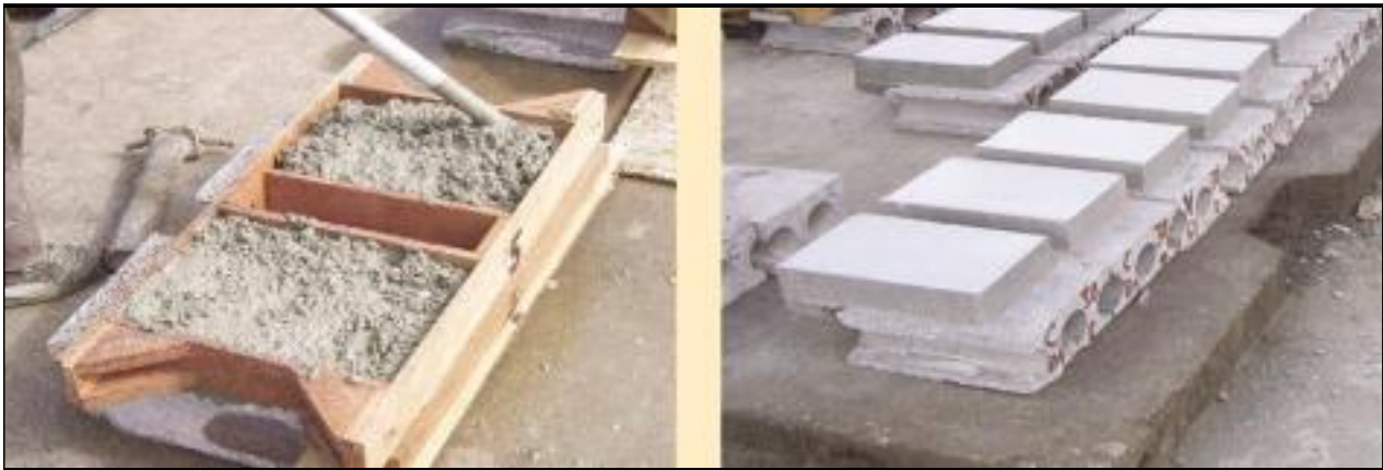
FIGURA 4. Hormigonado de losa in situ sobre piezas prefabricadas.
