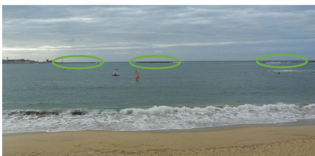
Figura 23. Reducción de oleaje incidente mediante obras de protección. Bahía de Saint Jean de Luz, 14/9/2015. Fotografía del autor.
