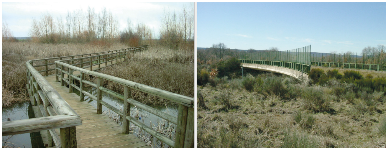
Figura 2. Ejemplos de infraestructuras verdes: izqda., complejo lagunar restaurado y acondicionado para el uso público en La Nava (Palencia); dcha., paso superior para fauna en la autovía de las Rías Bajas (A-52, Zamora). En ambos casos se trata de elementos que cumplen variadas funciones socioambientales, bien integradas en el territorio y con bajas necesidades energéticas y de mantenimiento.
