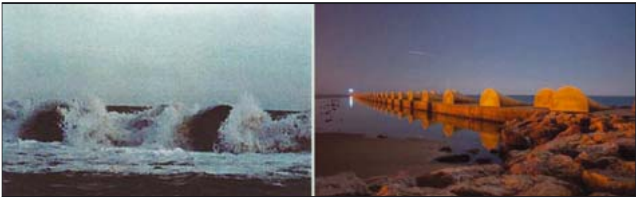
FIGURA 6. Control de la agitación del mar por el dique de Cubelles (Barcelona) (Izda.) y detalle del dique (Dcha.).
