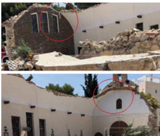
Figura 25. Formalización de la rótula de colapso en los apoyos transversales de la bóveda.
