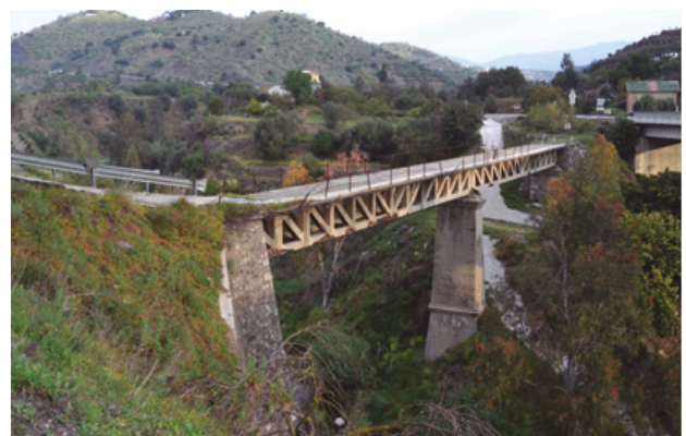
Figura 28. Segundo puente sobre el río Guaro. Fotografía del autor.
