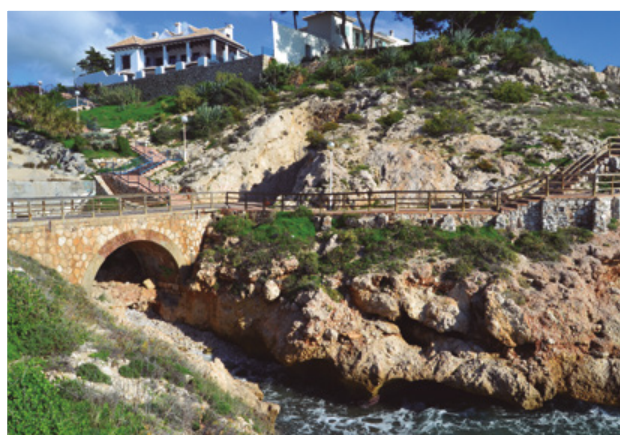
Figura 5. Puente del antiguo camino de Vélez (1796) en el Cantal de la Victoria, reutilizado para la línea de los FSMa. Fotografía del autor.
