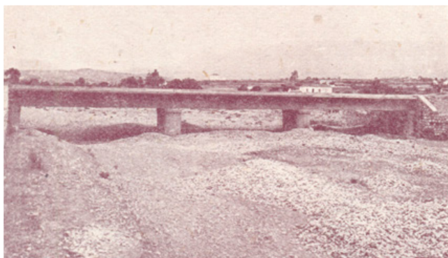
Figura 15. Puentes resueltos con tramos \pi en la línea de Málaga a Fuengirola: Río Real (3 tramos de 10 m) y Arroyo Pajares (2 tramos de 10 m). Hacia 1943. En Mendizábal Peña, 1943. Biblioteca de la Universidad de Málaga.
