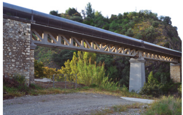
Figura 27. Primer puente sobre el río Guaro. Fotografía del autor.
