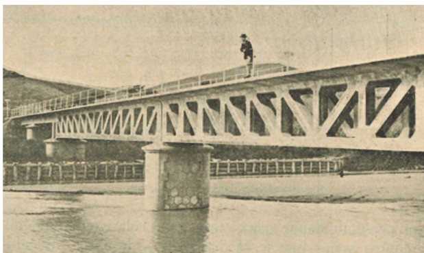
Figura 12. Puente sobre el río de Vélez hacia 1910. Revista de Obras Públicas . Universidad de Granada. Biblioteca del Hospital Real.
