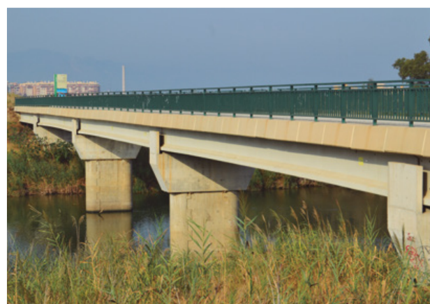
Figura 22. Viaducto de uno de los brazos de la desembocadura del Guadalhorce en la actualidad. Pilas originales de 1909. Fotografía del autor.
