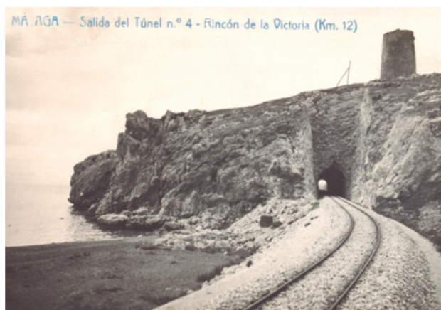
Figura 4. Salida del túnel nº 4 del Cantal de la Victoria (Málaga). Tarjeta postal de principios del siglo XX. Colección del autor.
