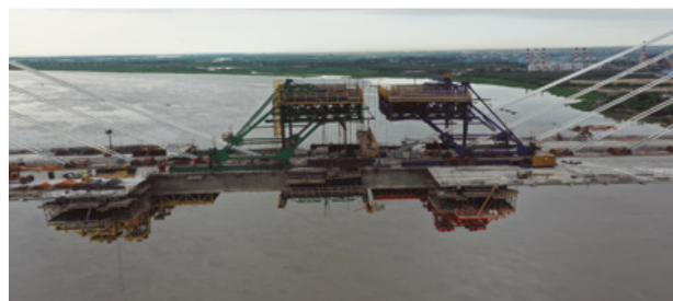
Figura 53. Vigas de continuidad en cierre vano principal.
