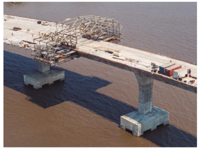
Figura 25. Vista aérea carro de alas accesos.
