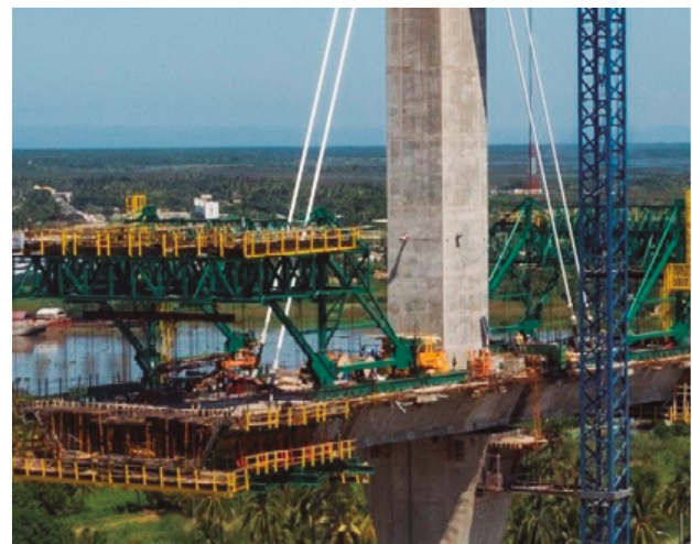
Figura 37. Ejecución de las dovelas cajón 2 una vez dispuestas las primeras 2 parejas de tirantes de cada lado y liberado el empotramiento provisional contra el pilono.
