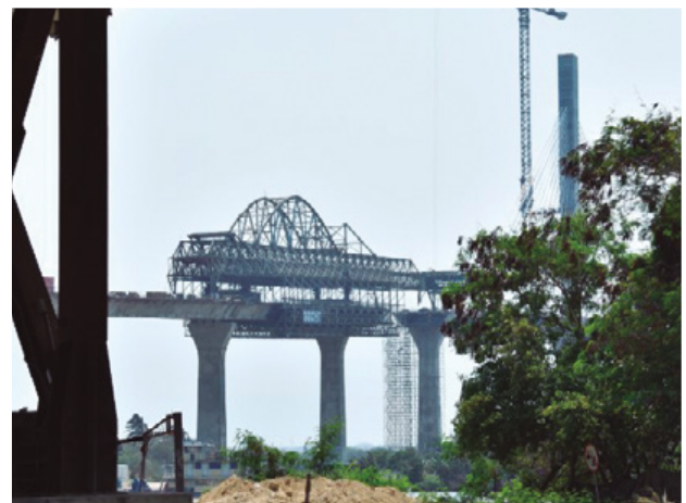
Figura 34. Punto fijo en margen derecha.
