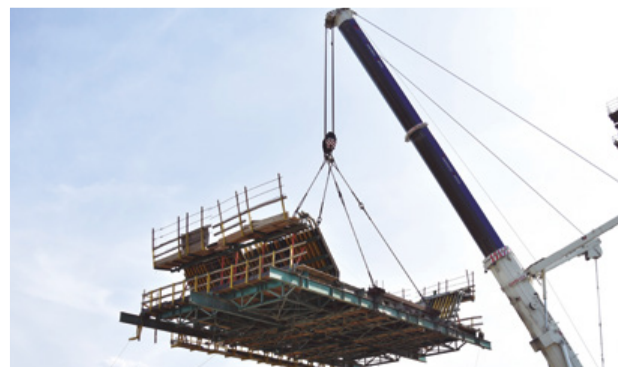
Figura 52. Flanqueo plataforma inferior carro de avance pila 12.
