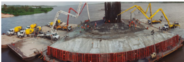
Figura 49. Hormigonado encepado pilono P13 desde pontonas.
