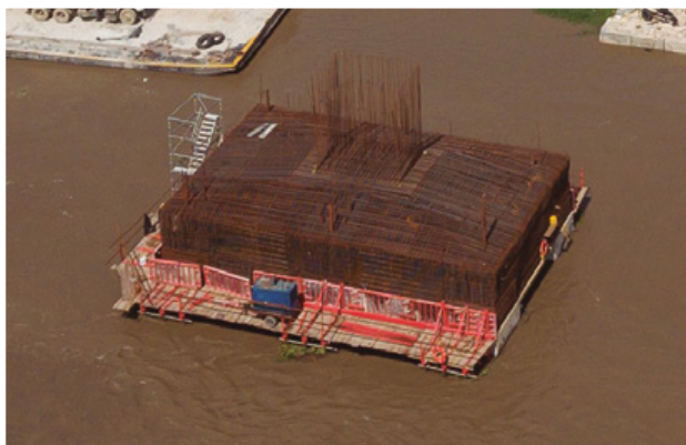
Figura 17. Cimentación ejecutada en agua.
