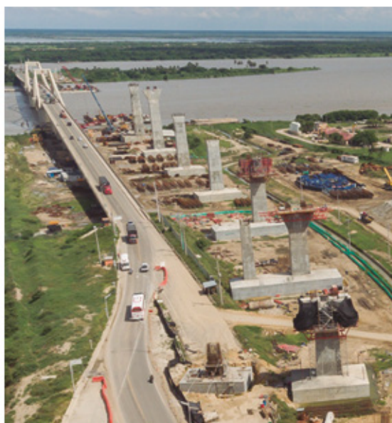
Figura 18. Alzado de fuste y capitel de las pilas de los vanos de acceso. Fustes pilas ejecutadas.
