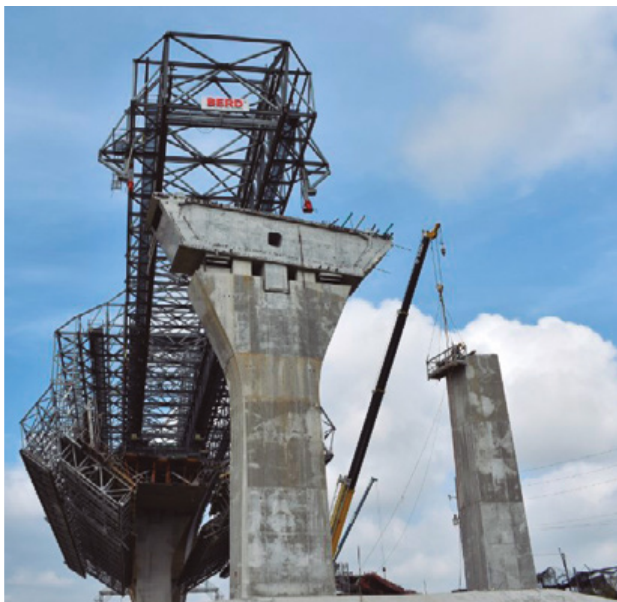
Figura 28. Autocimbra en avance a vano 21.
