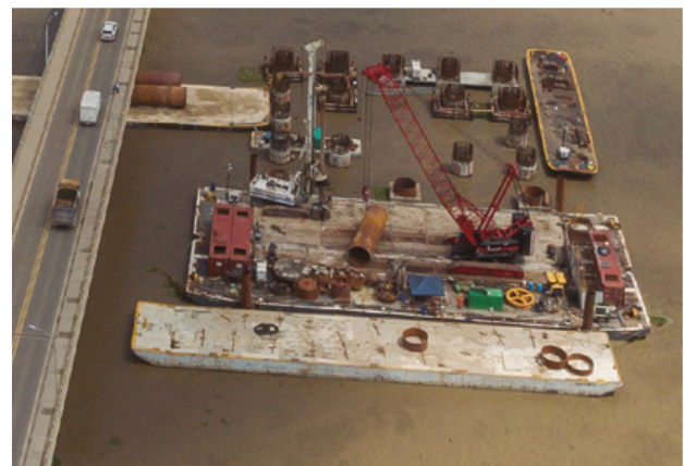
Figura 48. Ejecución pilotes encepado pilono P13 desde pontonas.
