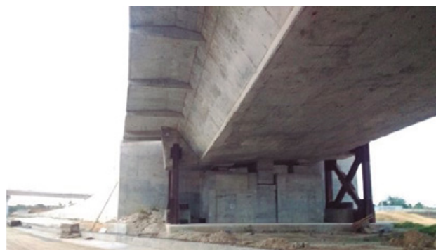
Figura 22. Puntos fijos provisionales en fase constructiva.
