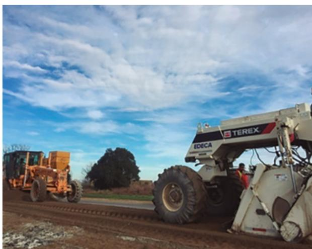
Figura 9. Perfilado del material luego de haberse mezclado con el estabilizante.
