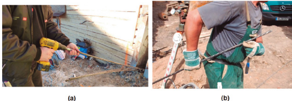
Figura 17. Recuperación del tirante en anclaje QuickEx: a) rotación del cable, b) extracción del cable de manera manual (Bogdan y Wörle, 2018).
