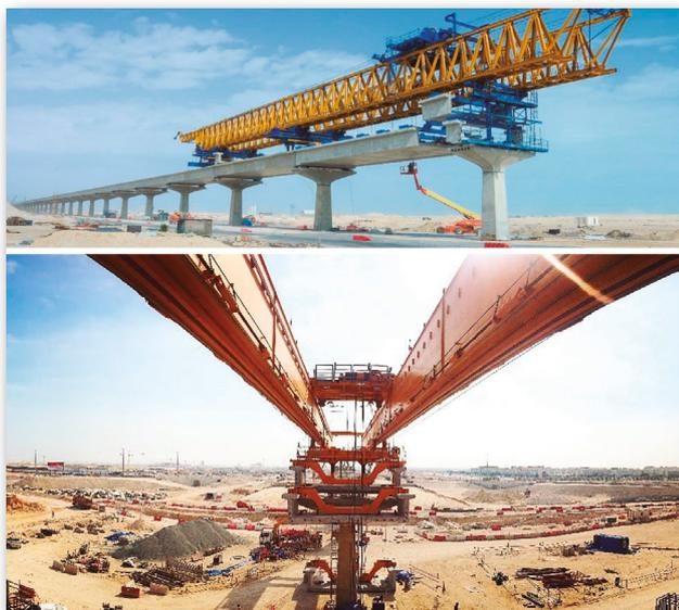
**Figura 5.** Distintas fases de construcción de viaducto del tramo línea Roja del Metro de Doha.
